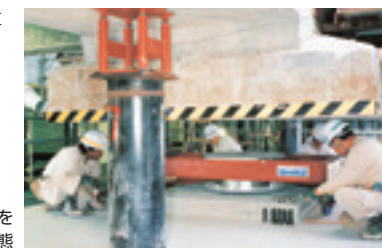
本館基礎を 鋼管杭で仮受けした状態
