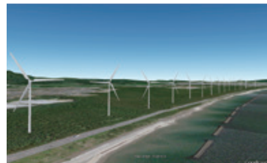
©Google 秋田潟上ウインドファーム発電所(完成予想図)(秋田県潟上市・秋田市) 22基の風車による発電施設を建設、2020年稼働を目指す
