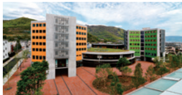
山梨学院大学国際バカロアラーツ学部棟(設計施工(共同設計))
