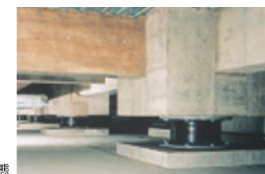
免震装置を設置した状態
