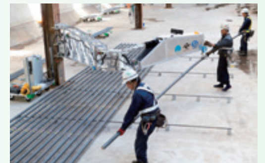
「配筋アシストロボ」稼働テストの様子
