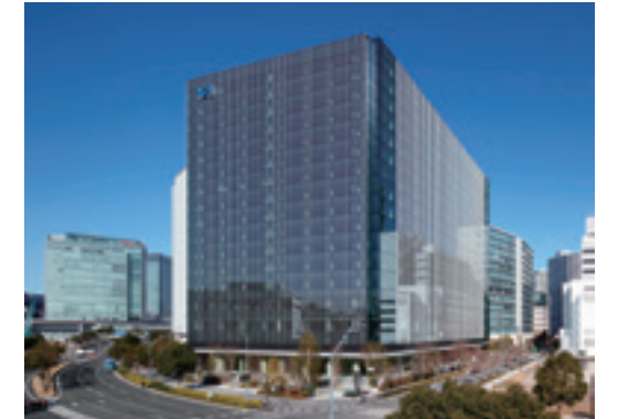
横浜野村ビル(神奈川県横浜市)
