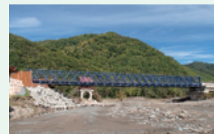
仮設の千呂露橋(復旧工事の進捗に伴い撤去済)
