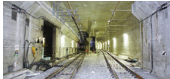
日本初の地下鉄営業線の平面交差解消事業 —鉄道7路線の安定輸送を可能にした東京メトロ有楽町線・副都心線連絡線設置工事—
