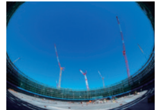
石狩LNG基地建設工事(北海道石狩市)
