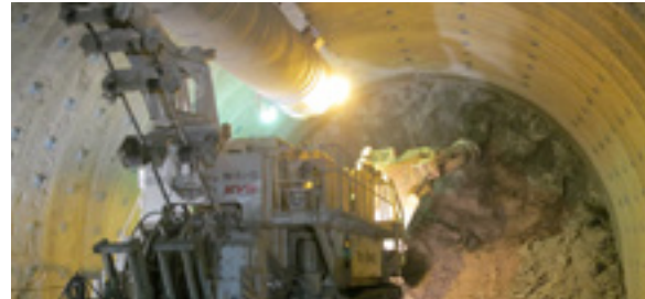
全断面機械掘削早期閉合法による脆弱地山への挑戦 —中部横断道・八之尻トンネル—
