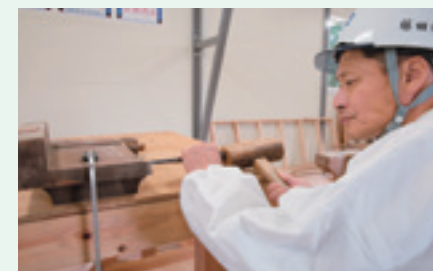
宮大工による修復作業の様子
