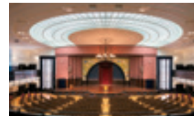
東京大学大講堂(安田講堂)(施工)(撮影:小川重雄)
