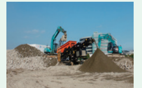
大型解体工事でがれき類を自ら利用
