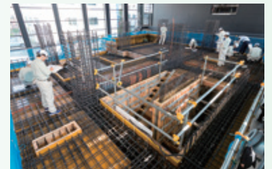
鉄筋検査の研修風景
