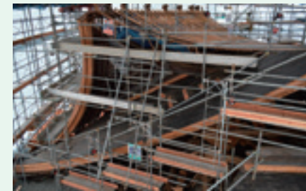
解体・調査が進む素屋根内部の様子
