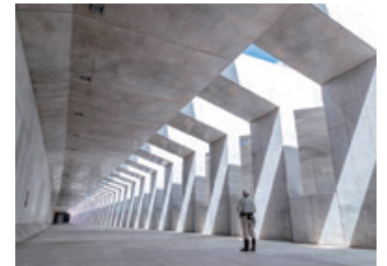
東京外環自動車道田尻地区函渠その6工事(千葉県市川市)
