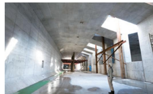
\*2 ボックスカルバート：地中に埋設される箱型の構造物
