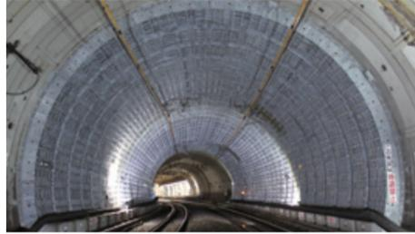
荷重増による鉄道シールドトンネルの変状に対する恒久的な対策工事-高島トンネル補強工事-
