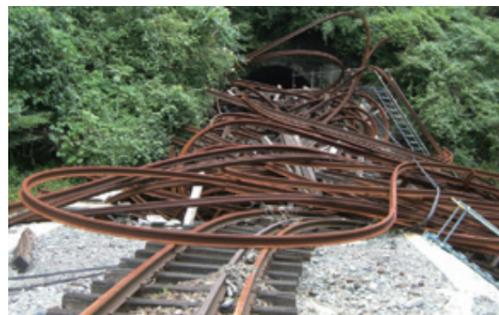
土石流で流し出されてトンネルをふさいだレール(被災直後)
