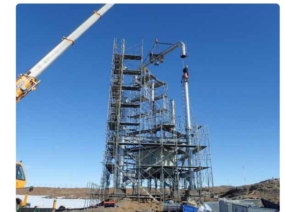
建設途中の風力発電装置 3 号機
