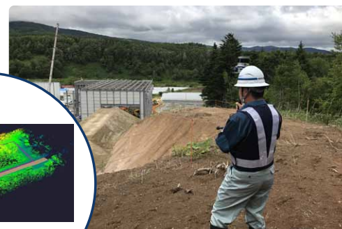
3次元レーザー距離計による 測量システムの検証状況
