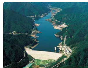
摺上川ダム (福島県/平成18年)
