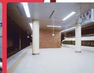
上野地下駅 (東京都/昭和60年)
