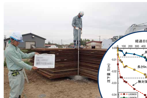
丸太打設による軟弱地盤対策(LP-SoC) 工法の大規模平板荷重試験実施状況
