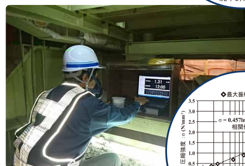
覆工コンクリート脱枠強度 管理システムの検証状況
