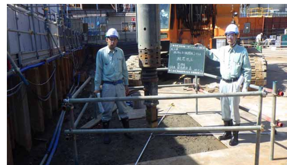
工事監理 設計通りに施工がされているか、監理者が確認します。
