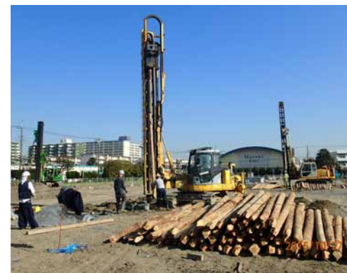
都市での施工状況
