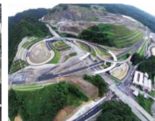
紀北西道路岩出IC (和歌山県/平成27年)
