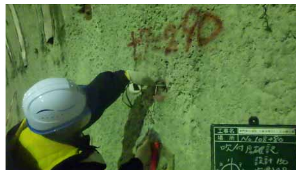
中間社内検査 社内検査員が構築した寸法・品質に問題はないか、確認します。
