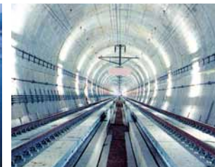
青函トンネル・算用師工区 (青森県/昭和57年)
