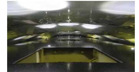
型枠天端部の状況
