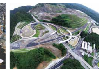
紀北西道路岩出IC (和歌山県/平成27年)
