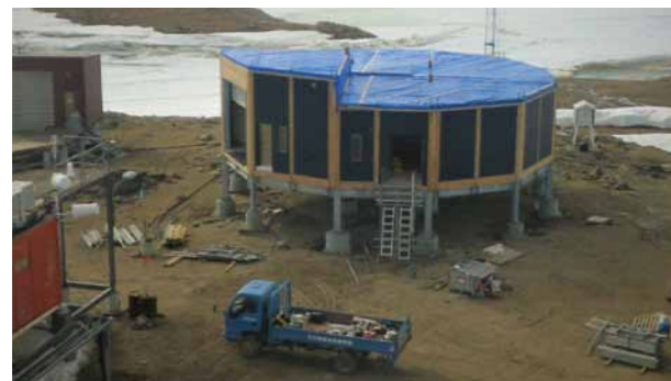
基本観測棟工事・1階工事
