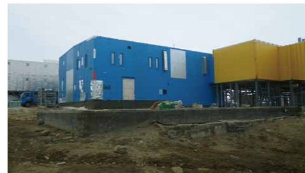
汚水処理棟解体工事
