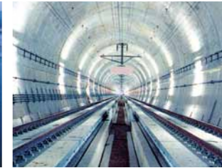
青函トンネル・算用師工区 (青森県/昭和57年)
