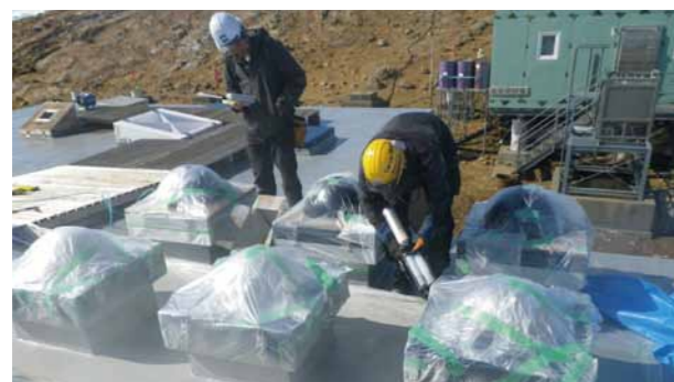
情報処理棟天窗追加工事
