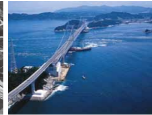
本四連絡橋・大鳴戸橋 (徳島県/昭和56年)
