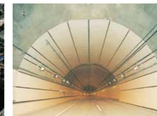
東京湾アクアライン・川人南工区 (神奈川県/平成9年)
