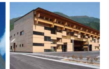
枹原町総合庁舎/2014年公共建築賞受賞 (高知県/平成18年)
