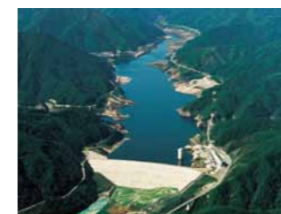
摺上川ダム (福島県/平成18年)
