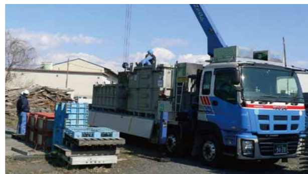
PCB 廃棄物の搬出状況
