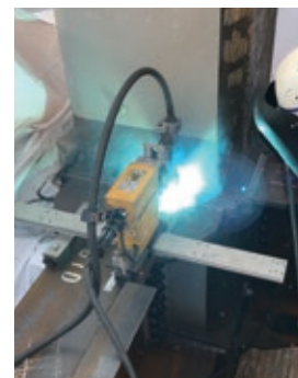
可搬型溶接ロボットによる超狭間先溶接
