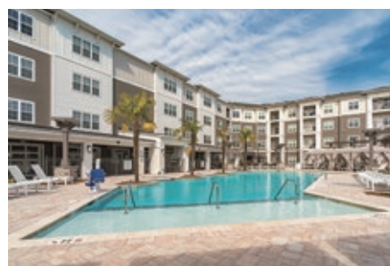
賃貸集合住宅「アンバーリーサウス」／フラワノイ社（米国）
