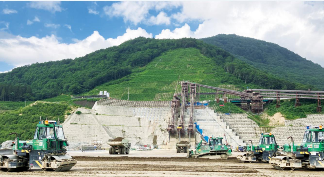
A4CSELを導入し、自動化建設機械で堤体打設作業を行う成瀬ダム現場（2023年8月撮影）
