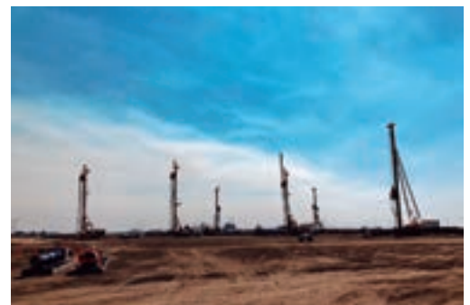
米国オレゴン州ウッドバーン市での施工中の様子
