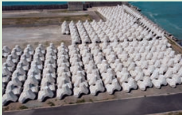
工事名称：室津港室津地区防波堤（Ⅱ）工事 （100t型ドロスⅡ型） 事業主体：国土交通省四国地方整備局 施工場所：高知県室戸市
