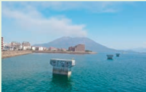
工事名称：令和元年度鹿児島港（鴨池中央港区） 臨港道路橋脚P8下部工工事 事業主体：国土交通省九州地方整備局 施工場所：鹿児島県鹿児島市
