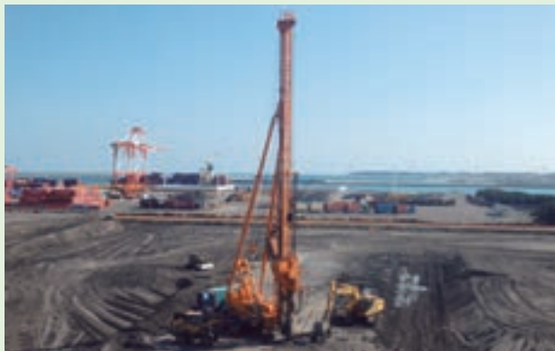
工事名称：常陸那珂火力発電所 産業廃棄物最終処分場 埋立地管理業務委託工事 事業主体：株式会社JERA （元請会社：東京パワーテクノロジー株式会社） 施工場所：茨城県那珂郡東海村
