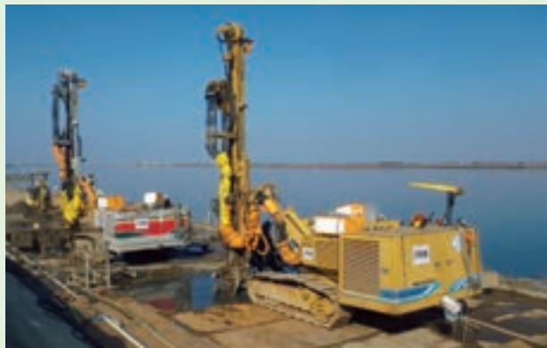
工事名称：令和元年度 木曽川赤地川表高潮堤防補強工事 事業主体：国土交通省中部地方整備局 （元請会社：株式会社新井組） 施工場所：三重県桑名市
