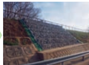
復旧工事完了後
