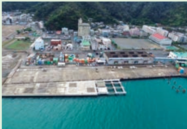
工事名称：平成30年度名瀬港（本港地区）岸壁(-7.5m) （改良）工事（第3次） 事業主体：国土交通省九州地方整備局 施工場所：鹿児島県奄美市
