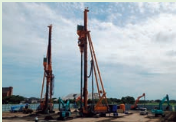
工事名称：旭市新庁舎建設建築工事 事業主体：千葉県旭市 （元請会社：奥村・阿部特定工事共同企業体） 施工場所：千葉県旭市
