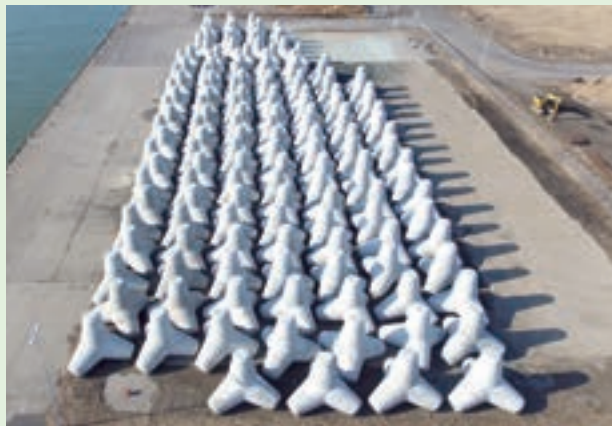
工事名称：留萌港ブロック製作工事(80t型テトラポッド) 事業主体：国土交通省北海道開発局 施工場所：北海道留萌市
