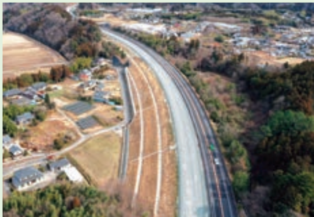
工事名称：常磐自動車道 平窪工事 事業主体：東日本高速道路株式会社 施工場所：福島県いわき市
