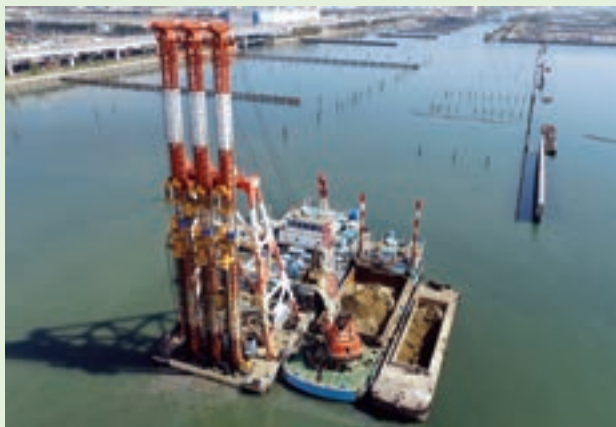
工事名称：弥富ふ頭第1貯木場北側地盤改良工事（その2） 事業主体：名古屋港管理組合 （元請会社：みらい建設工業株式会社） 施工場所：愛知県名古屋市中区
