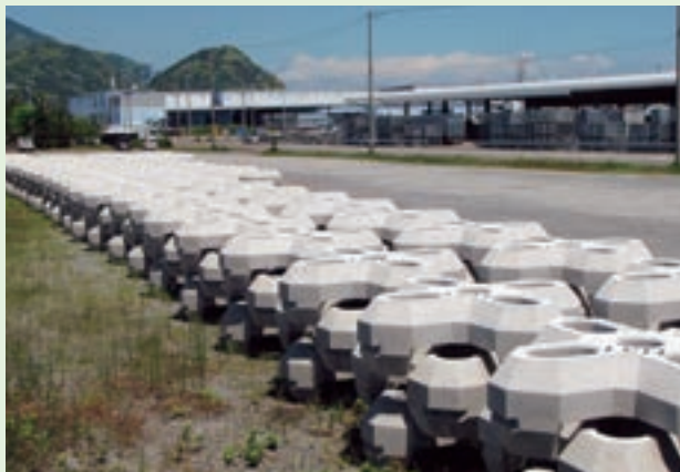
工事名称：焼津漁港水産流通基盤整備(特3種外郭) 焼津南防波堤(改良) 工事(粘り強い対策工) (2t型ペルメックス) 事業主体：静岡県 施工場所：静岡県焼津市
