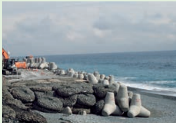
工事名称：西湘バイパス災害対策工事（4t型フィルターユニットS型） 事業主体：国土交通省関東地方整備局横浜国道事務所 施工場所：神奈川県中郡大磯町
