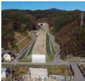
宮古側坑口および土工区間
