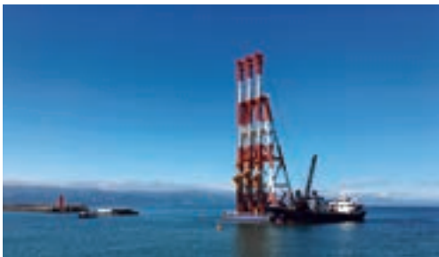
石狩湾新港北防波堤建設工事で施工する 「ばいおにあ第30フドウ丸」
