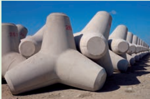
工事名称：廃棄物響灘東護岸（消波ブロック製作） 工事関連（25t型テトラポッド） 事業主体：北九州市 施工場所：福岡県北九州市
