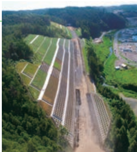
事業主体：国土交通省東北地方整備局 施工場所：宮城県本吉郡南三陸町
