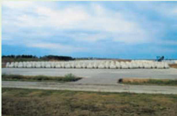
工事名称：金沢港（大野地区）防波堤（西）（改良） 消波工事関連（65t型ドロスⅡ型） 事業主体：国土交通省北陸地方整備局 施工場所：石川県金沢市
