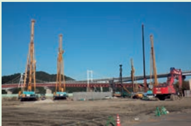
工事名称：撫養港海岸桑島瀬戸地区堤防改良工事(その7) 事業主体：国土交通省四国地方整備局 施工場所：徳島県鳴門市
