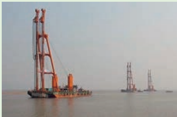
工事名称：ラックフェン国際港整備工事(パッケージ6) 事業主体：ベトナム政府 施工場所：ベトナム社会主義共和国 ハイフォン市
