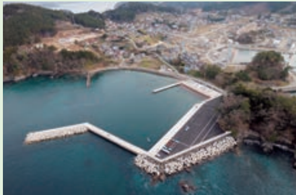
工事名称：広田漁港災害復旧(23災県第342号ほか)工事 事業主体：岩手県 施工場所：岩手県陸前高田市
