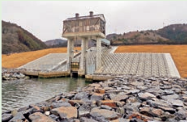
工事名称：北上川下流横川地区排水樋管・機場新設工事 事業主体：国土交通省東北地方整備局 施工場所：宮城県石巻市
