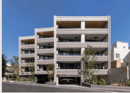
■ 若林一丁目PJ新築工事（東京都）
