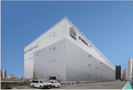
■ 尼崎物流施設PJ新築工事（兵庫県）
