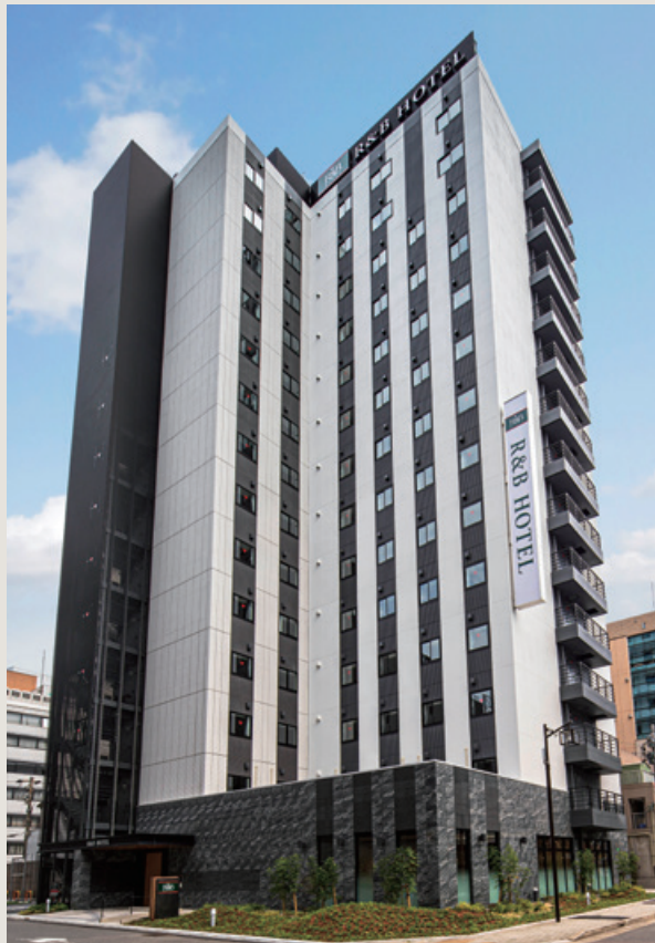
■ R&Bホテル名古屋駅前計画新築工事（愛知県）
