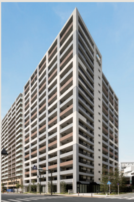
■ レーベン本厚木新築工事（神奈川県）
