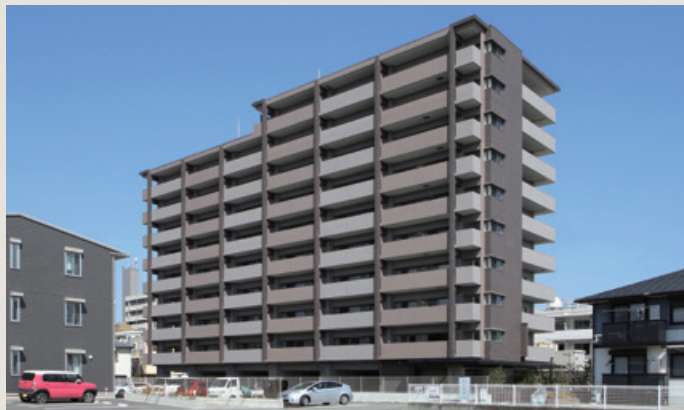
■ アルファステイツ中吉野町Ⅱ新築工事（徳島県）
