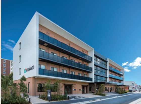
■ ASMACI浦安富岡新築工事（千葉県）
