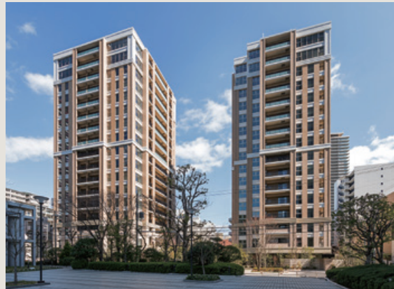
■ 大阪市北区中崎西プロジェクト工事（大阪府）
