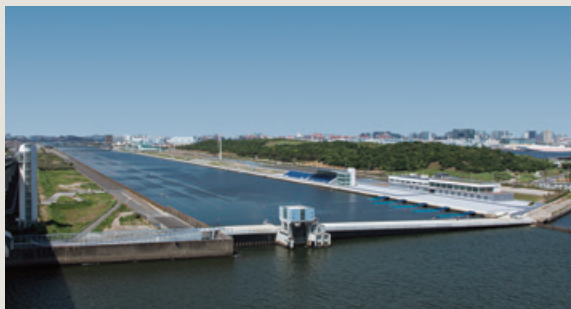
■ 平成27年度海の森水上競技場整備工事（東京都）
