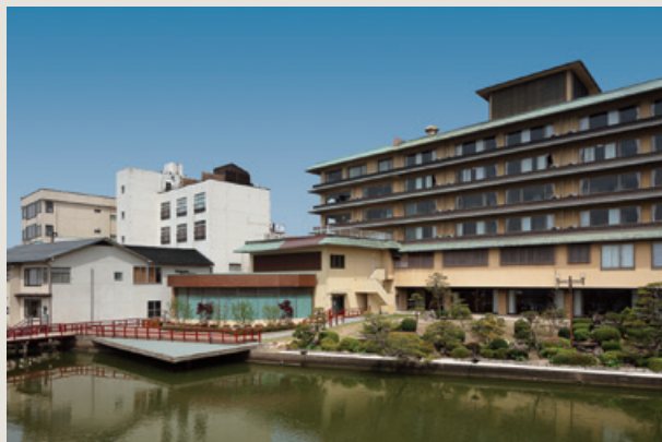
■ 山陰はわい温泉望湖楼改修工事（鳥取県）
