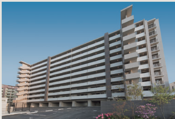
■ アルファスマート南熊本新築工事（熊本県）
