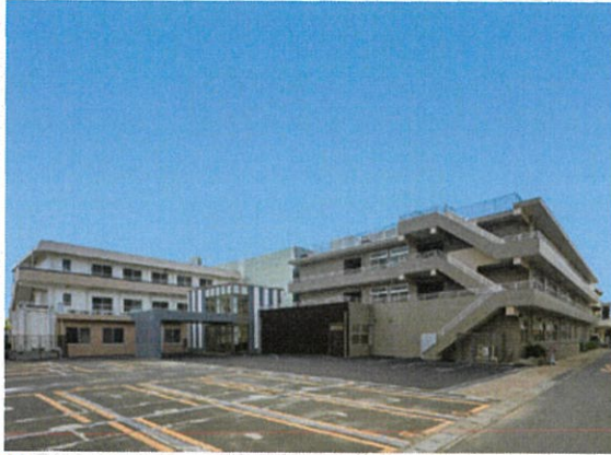
■ TMGサテライトクリニック朝霞台増改修工事 (埼玉県)
