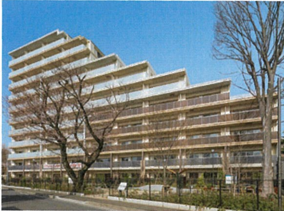
■ プレミスト東林間新築工事 (神奈川県)
