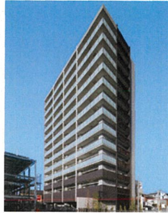
■ 柏原市古町1丁目新築工事 (大阪府)
