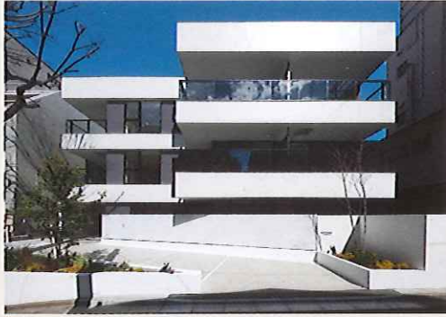
■ 富士見2丁目ビルリファイニング工事 (東京都)
