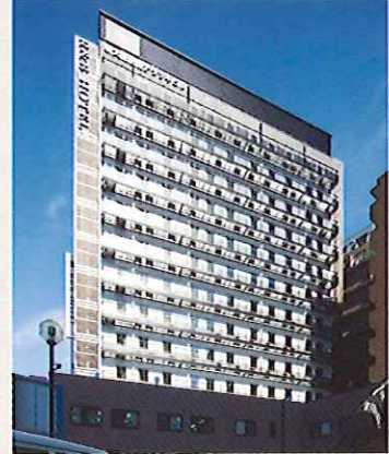
■ 新大阪駅前テラスキビル新築工事 (大阪府)
