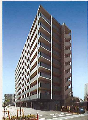
■ アルファステイツ野田Ⅲ新築工事 (岡山県)
