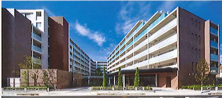
■ プライム新杉田新築工事 (神奈川県)
