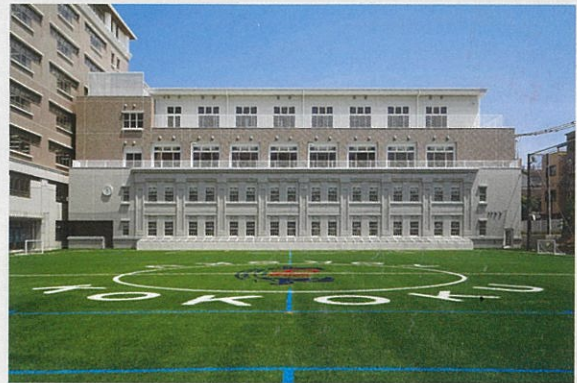
■ 興國高等学校アリーナ [新北館] 増築工事 (大阪府)
