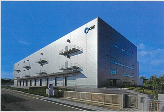
■ ロジスクエア新座新築工事 (埼玉県)
