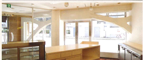
■ 九州安達学園耐震補強工事（福岡）
