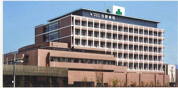
■ 交野病院新築工事（大阪）
