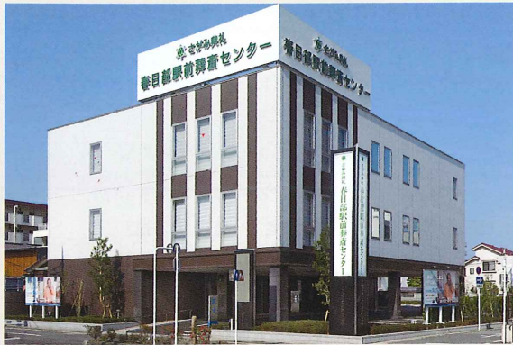
■ アルファクラブ武蔵野春日部駅前葬斎センター新築工事（埼玉）
