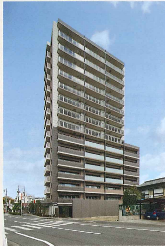
■ ライオンズ豊明栄町新築工事（愛知）
