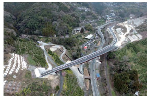
当社はそのうち2023年3月に開通した八幡浜道路区間にある支間長135mにわたるJR予讃線と国道197号をまたぐ「千丈高架橋」の新設を行いました。幅員と桁高が変化する複雑な形状の鋼2径間連続鋼床版桁橋で難易度の高い工事でした。送り出しは計6回に分けて行い、精密な3Dモデルの作成や自動追尾計測で桁位置をリアルタイムに把握するなど、ICT技術を積極的に活用し、持続可能な社会基盤の整備に貢献しました。
