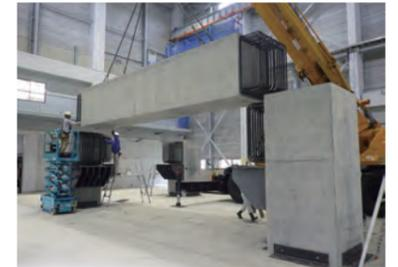
建設技術総合センターに設置した「プレキャスト高架橋の実物大の部材」
