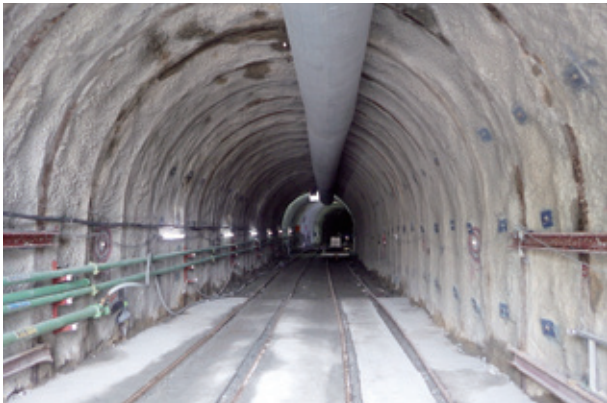
工事が進むトンネル内の様子
