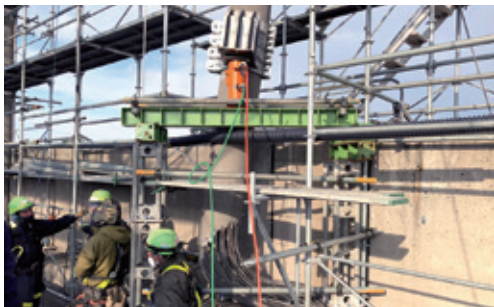
折損した電化柱の復旧工事の様子
