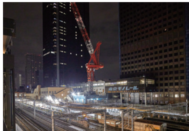
2022年5月に行われた浜松町駅線路切換工事(BIMを活用し切換工事の施工計画を検討)
