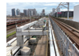
上りホーム桁施工
