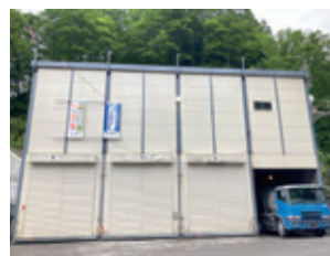
バッチャープラント
