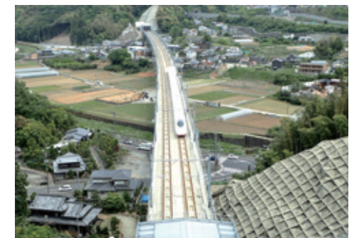
経ヶ岳トンネル(当社施工) 付近を通過する試運転中の西九州新幹線
