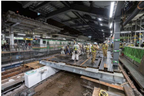
第3回線路切換工事の様子
