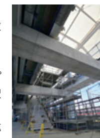
膜屋根吹き抜け構造のコンコース
