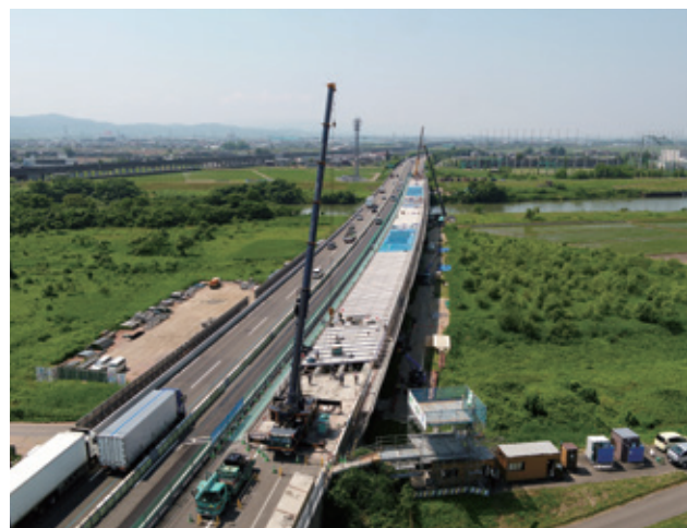
北陸自動車道 栄橋床版取替工事 老朽化した信濃川に架かる橋梁の床版を耐久性の高いPC床版に取り替える工事
