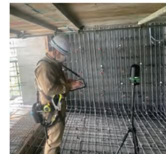
点群から鉄筋モデル化
