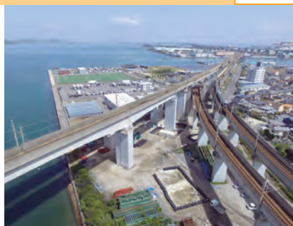
本四備讃線 耐震補強
