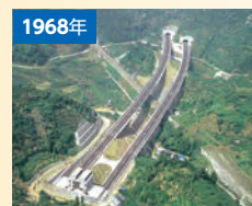
東名高速道路・袖師工区
