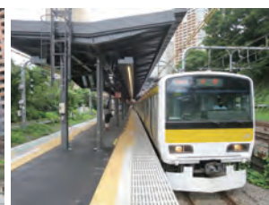
安全性が向上したホーム
