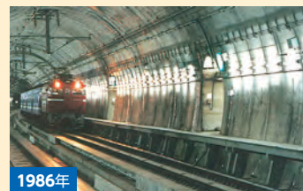
青函トンネル・竜飛工区
