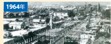
東京メトロ日比谷線長谷戸工区
