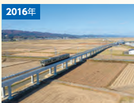
東日本大震災復旧 JR常磐線山下工区
