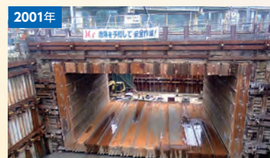
県道・JR上越線交差点部 塩沢ご道橋（HEP&JES工法）
