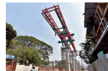
スパンバイスパン工法区間に設置された架設ガーダー
