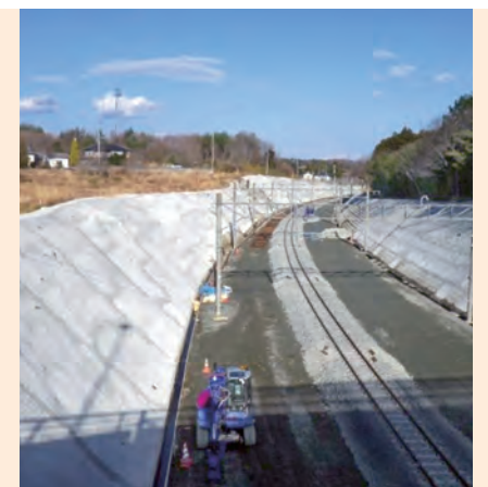
常磐線電田-浪江間の災害復旧工事
