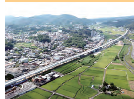
九州新幹線(西九州)、柴田高架橋他
