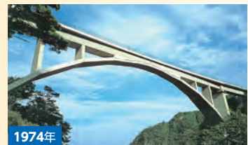
久慈線大沢橋梁
