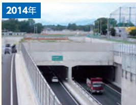
圏央道・JR高崎線交差点部 ニツ家ご道橋（地盤切削JES工法）
