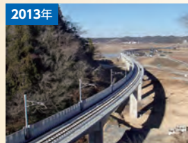
東日本大震災復旧 JR仙石線野蒜工区
