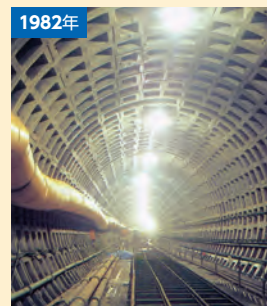
東京メトロ有楽町線氷川台工区
