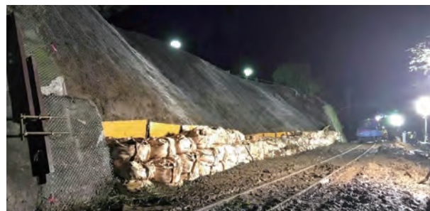
24時間、軌道内で進む法面工事
