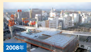
エキュート立川（ソード工法）
