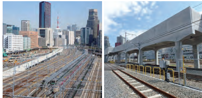
新たに整備された路盤と高架橋
