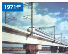
山陽新幹線加古川橋梁
