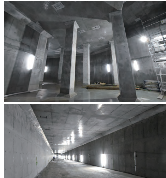
完成した機械室躯体(上)と歩行者通路躯体(下)
