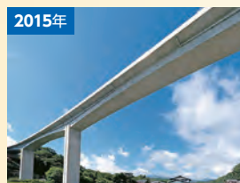
中部横断自動車道 大石川橋上部工事
