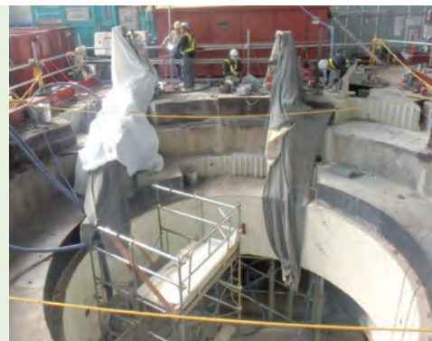
CWF(完全無水)工法によるコンクリート床切断の様子
