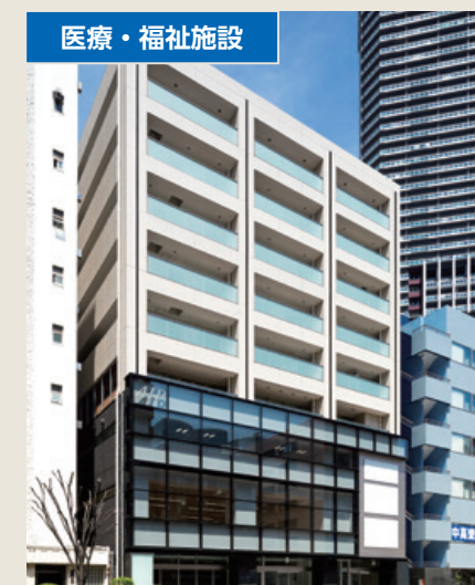
AIP勝どき駅前ビル（複合型高齢者施設） 東京都港区
