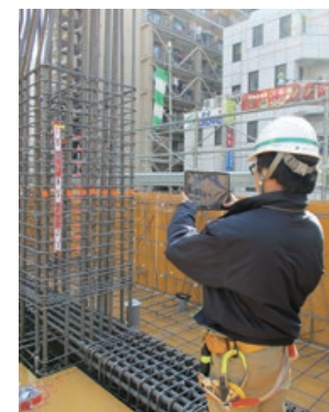
iPadによる工事写真撮影
