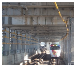
営業線に近接した橋脚も補強
