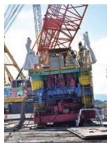
斜杭により水平剛性を確保
