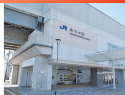
おおさか東線 西吹田駅・高架橋
