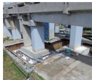
橋脚の繊維巻き立て補強と基礎補強
