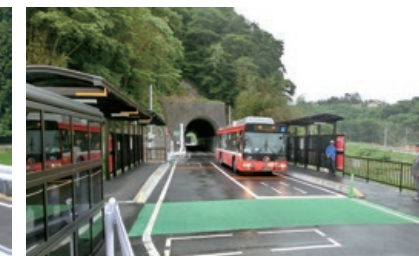
専用道の駅として2019年6月供用開始された清水浜駅
