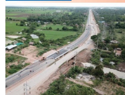
国道5号線改修CP1(カンボジア)
