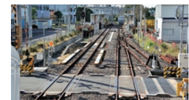
実物を使用した屋外研修設備
