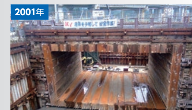
県道・JR上越線交差部 塩沼ご道橋（HEP&JES工法）
