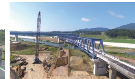
専用道路の建設が進む沼田川橋梁（2019年度中に供用開始予定）
