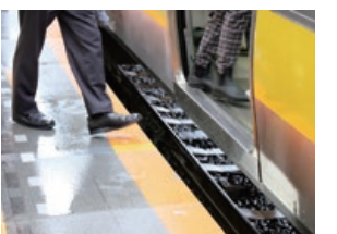
工事が完了すると列車とホームの間の「隙間」と「段差」が解消
