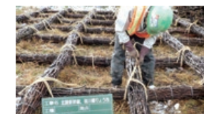
粗朶沈床の下格子組み立て
