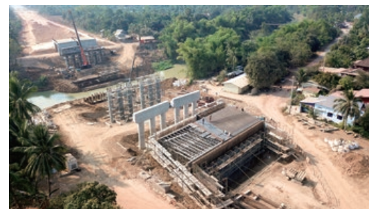
長さ128mの橋を新設するサンカー川は年間水位差が7m
