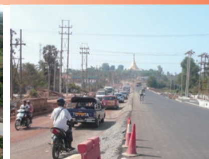
ティラワ地区アクセス道路改修(ミャンマー)
