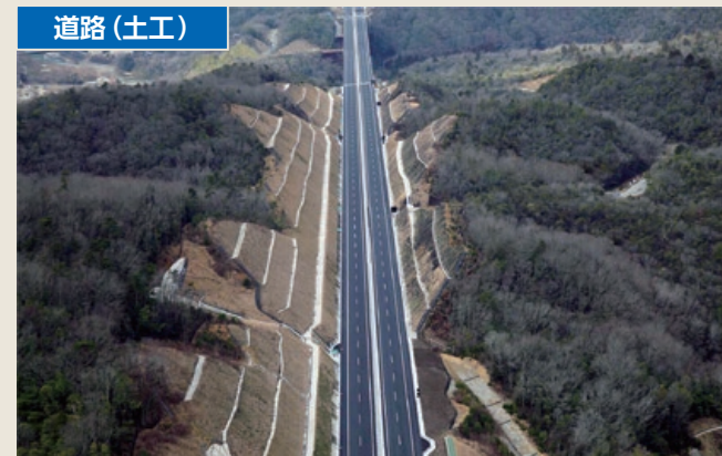
新名神高速道路 道場生野 兵庫県神戸市
