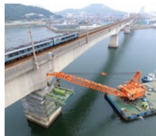
橋脚の落橋防止を海上で施工
