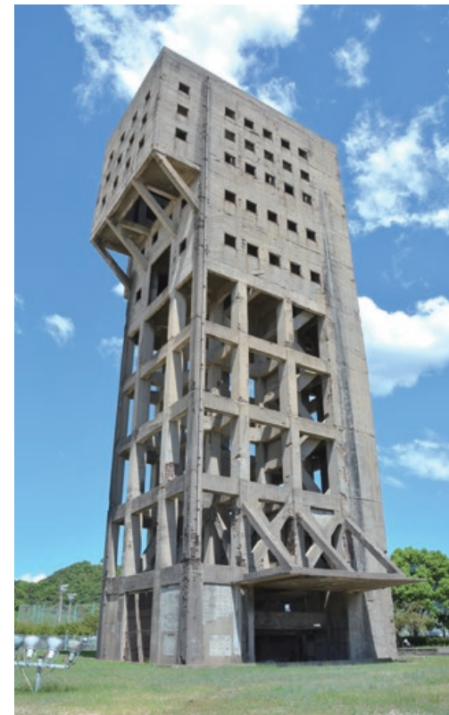
15階建てビルに相当する高さ47.6mの竪坑櫓。現存する国内最大級の石炭産業遺産として国の重要文化財に指定
