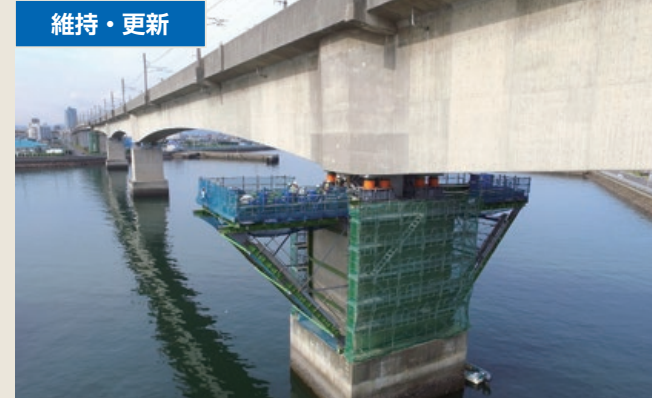
本四備讃線鉄道単独部 耐震補強 岡山県倉敷市
