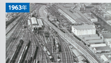
東海道新幹線品川駅付近高架橋/東京電車基地
