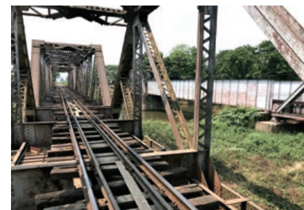
建設後90年以上経つ橋梁。健全度診断を行いできる限り既存を活かす
