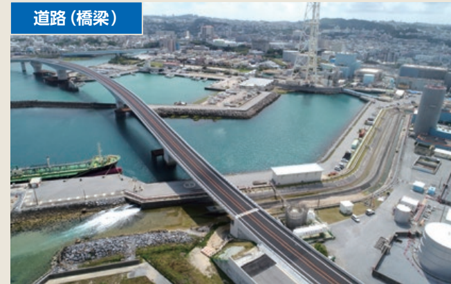
牧港高架橋 沖縄県浦添市
