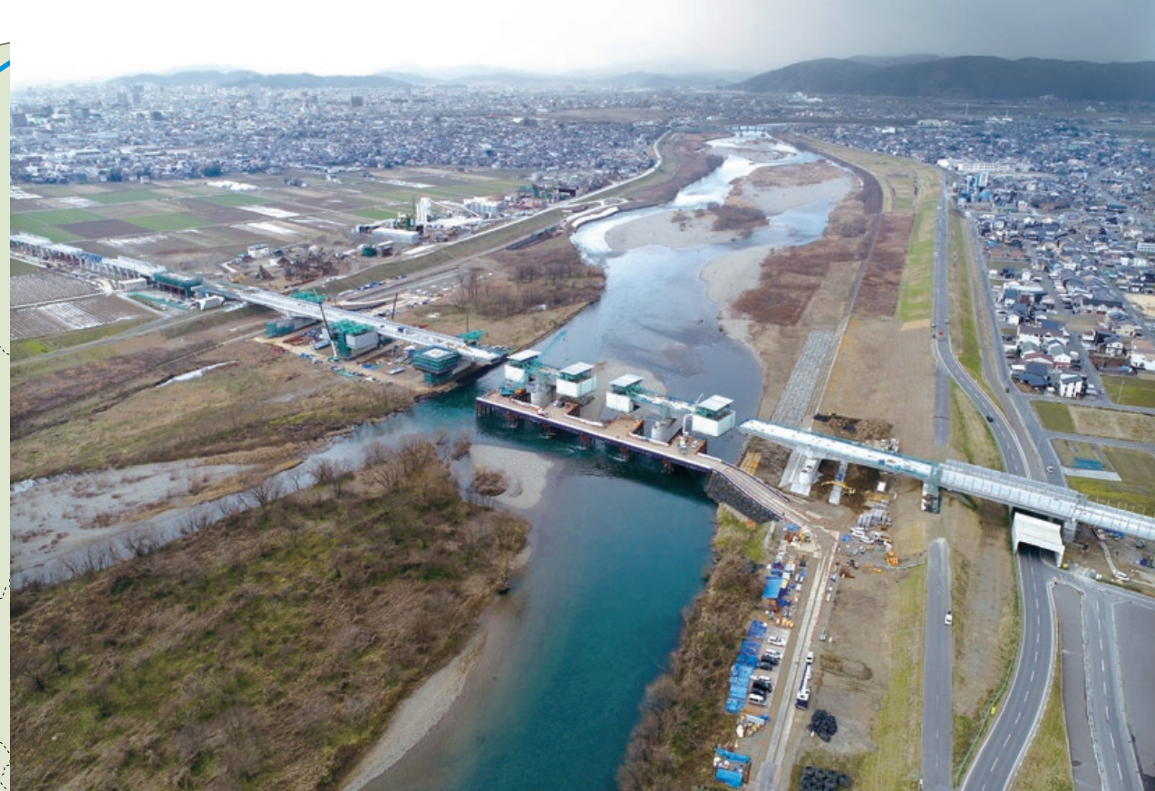
九頭竜川橋梁の全景（2019年2月撮影）
