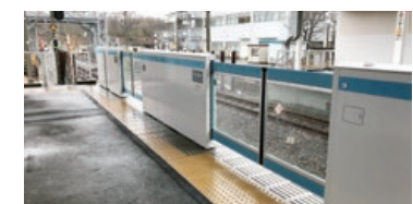
首都圏で増加しているホームドアを新設
