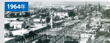
東京メトロ日比谷線長谷戸工区
