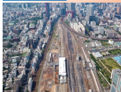
品川車両基地整備・高輪ゲートウェイ駅新設
