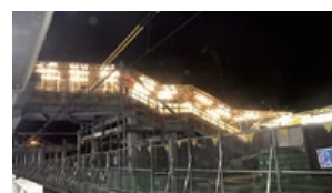
仮通路は約半年をかけて設置した
