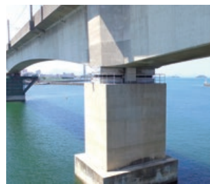
29tの鋼製支承をゴム支承に交換
