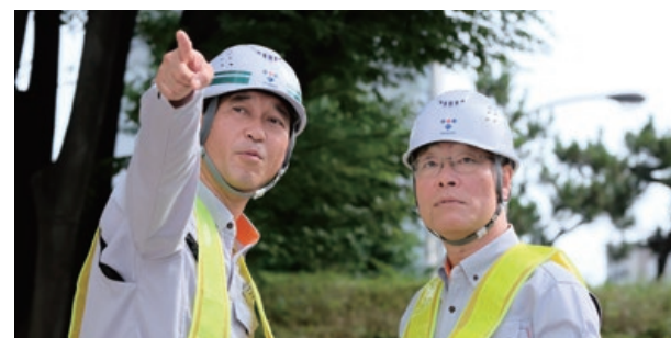
伊藤社長による現場パトロール
