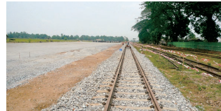
工事のための資材置き場と引き込み線
