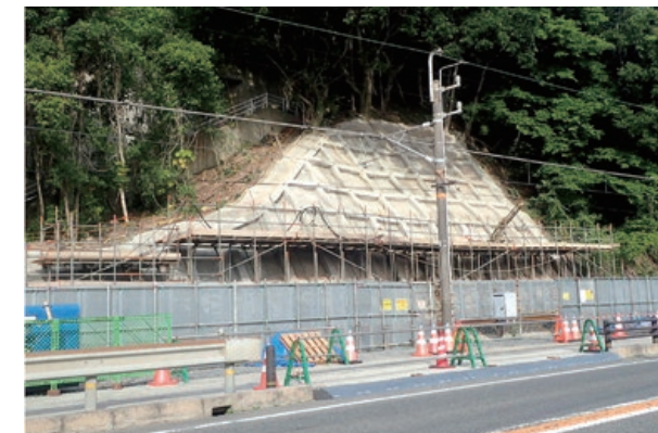
線路脇で崩落法面に吹付法枠を設置
