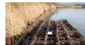
河床に沈める前の粗朶沈床
