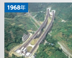
東名高速道路・袖師工区
