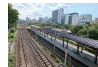
新設ホームは急勾配の箇所に移設するため、線路縦断勾配を緩やかに改良
