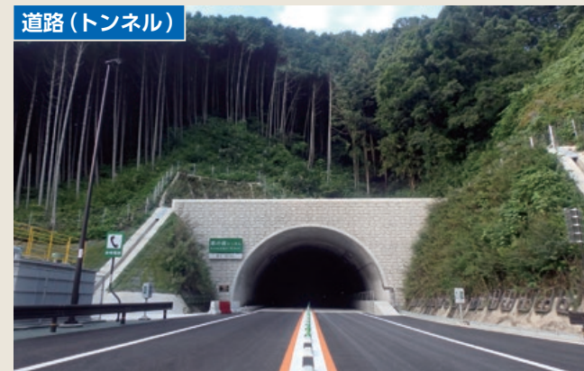
大和御所道路 新田東佐味トンネル 奈良県御所市
