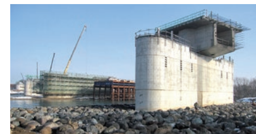
アラレガコや他の生物への影響を最小限にするため、護床の材料は九頭竜川の石を使用
