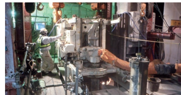
ホーム上仮囲い内での施工状況
