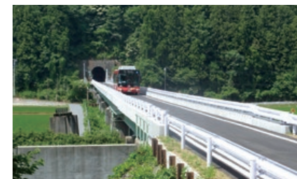
2018年7月に供用開始した専用道（柳津－陸前戸倉間）12kmを施工。写真は沼田橋梁
