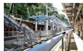
正月時のみ使用していた臨時ホームを山手線外回り専用ホームへ改築
