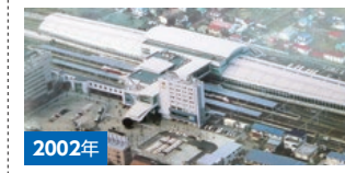
2002年 東北新幹線八戸駅 (青森県八戸市) 盛岡～八戸間の東北新幹線延伸計画の終着駅。地元協力のもと、当社の技術を結集し造り上げた。
