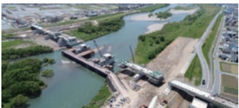
北陸新幹線 九頭竜川橋りょう
