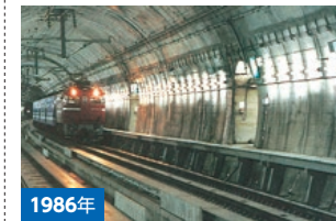
1986年 青函トンネル・竜飛区 (青森県東津軽郡) 本州と北海道を海底で結ぶ53.85kmの鉄道トンネル。着工から完成まで14年にわたりプロジェクトに携わった。
