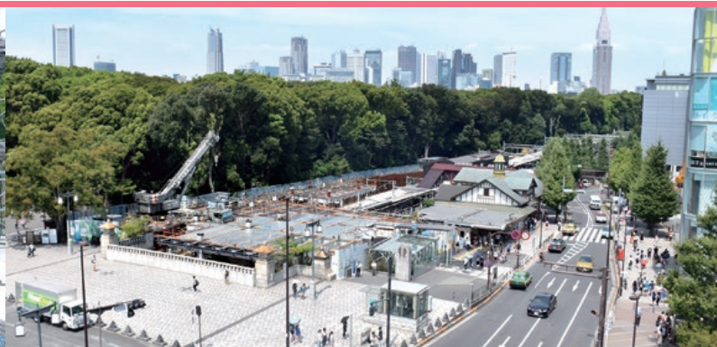
施工中の JR 原宿駅
