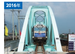
2016年 ハノイ～ホーチミン間 ベトナム国鉄23橋梁改修 (ベトナム) 戦争被害や老朽化により架け替えが必要となった10橋梁の改良工事。工事範囲の路線延長は230kmにもなった。
