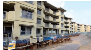
建物下で杭を修復中の秋津団地
