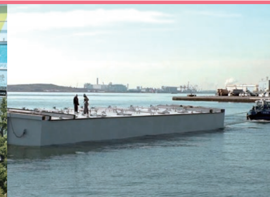
水上輸送される上平井水門のフローティングゲート
