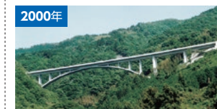
2000年 松山自動車道東峰橋 (愛媛県伊予郡) 2000年に開通した四国縦貫自動車道。急峻な谷をまたぐRC逆ランガーアーチ橋をトラス張出し架設工法で施工。
