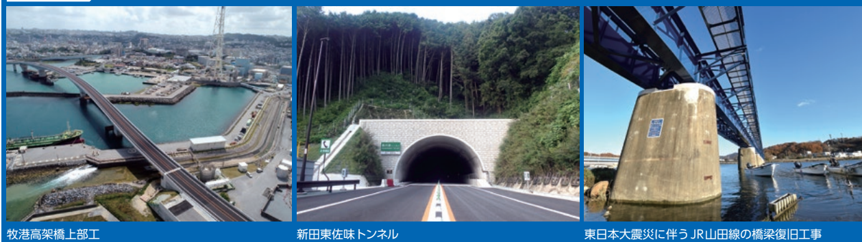
牧港高架橋上部工
