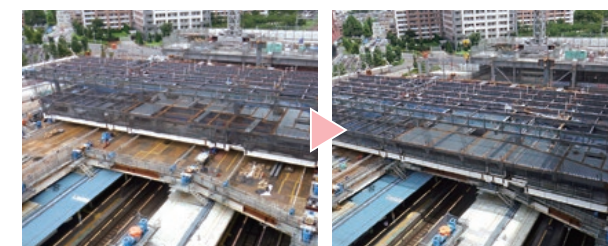
ソード工法はプラットフォームの上で躯体鉄骨をスライドさせる
