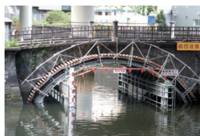
東日本大震災で変形した輪石を下から支える応急工事を行った
