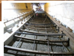
※インバート トンネル底面の逆アーチ形状をした覆工部分。トンネルの断面をリング状に併合することで、トンネルの変形を防止する。
