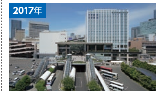
2017年 JR仙台駅 (宮城県仙台市) 線路上空に東西自由通路や駅ビル(エスパレ仙台 東館)、立体駐車場を、東口にはホテルメトロポリタン仙台イーストを建設。
