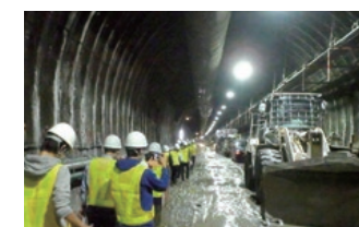
施工中の昆布トンネルを見学する学生
