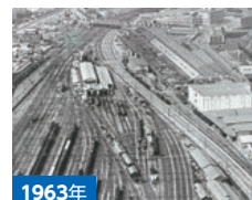
1963年 品川駅付近高架橋/東京電車基地 (東京都港区・品川区)
