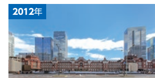
2012年 東京駅丸の内駅舎保存・復原 (東京都千代田区) 国の重要文化財である駅舎の復原工事。駅機能を維持しながら駅舎の免震化も実施。約5年4カ月を要した。
