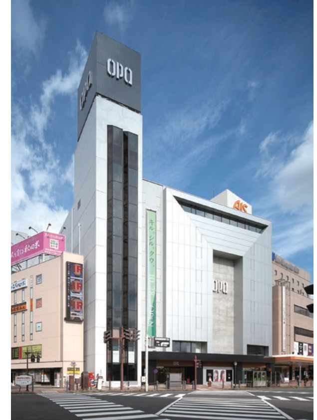
▲ 駅前広場側は、高さ6階分の連続する耐震壁を増設するとともに外壁を軽量化
