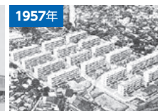
1957年 板橋共済アパート新築 (東京都板橋区) 国鉄共済組合の宿舎。1959年の池袋4丁目アパート(東京都豊島区)では国内初のディーゼルハンマーによる杭打設を行った。
