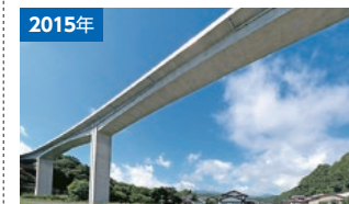
2015年 中部横断自動車道大石川橋上部工事 (長野県佐久郡佐久穂町)
