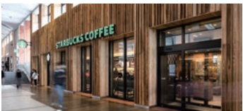
ノーザンステーションゲート 秋田プロジェクト
