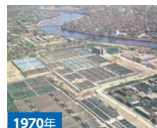
1970年 三河島下水処理場 (東京都荒川区) 1923年より運転を開始した東京で最も古い下水処理場。数度にわたる改修・増設が行われている。
