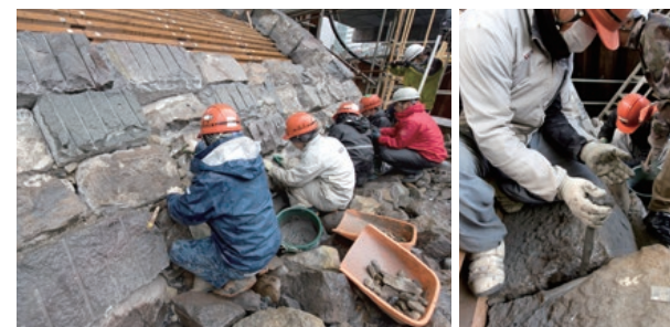
▲手作業で超高強度モルタルを輪石の隙間に充填。削岩機による直線のノミ跡がある輪石は新材 (写真：大村 拓也)
