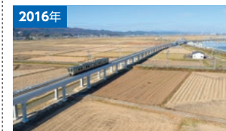
2016年 JR常磐線山下工区工事 (宮城県亘理郡山元町)
