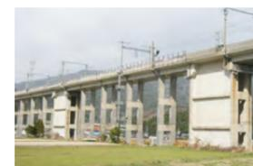
せん断補強はRB工法で、鉄筋段落とし部はアラミド繊維巻き立て工法で補強
