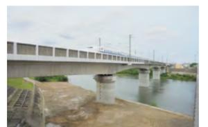
岡山市内の旭川橋梁の橋脚をRC巻き工法で施工
