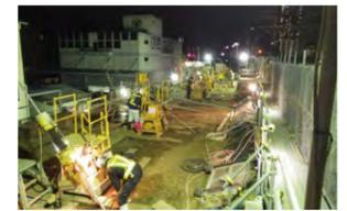
軟弱地盤対策として、少ない薬液量で盛土地盤を改良できる脈状注入を夜間に施工した
