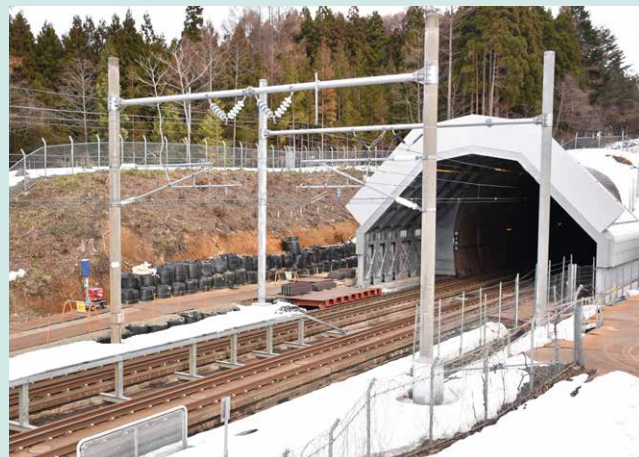
限界支障報知装置とトンネル緩衝工
