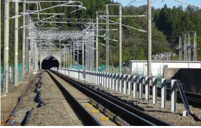
「限界支障報知装置新設工事、奥津軽保守区新築工事」 北海道新幹線開業めげ土木工事・建築工事それぞれが力を発揮し、工期限内に工事を完成させました。
