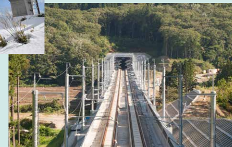
第二外黒山トンネル外1箇所他
