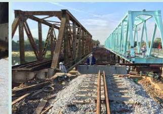
既設橋梁の横取り撤去作業
