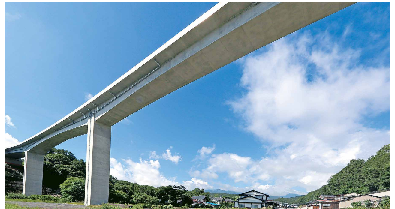
中部横断自動車道 大石川橋上部工事(長野県佐久穂町)
