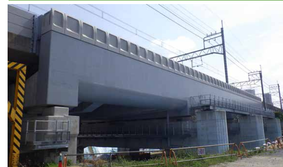
総武線市川・本八幡間外環こ道橋新設(千葉県市川市) 東京外環自動車道とJR総武線の交差点アンダーパス工事。高架橋を挟む両側にケーソン工法で函体を沈設。既設高架橋をアンダーピンングし構造物を構築。
