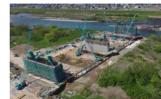
施工が進む、JV九頭竜作業所
