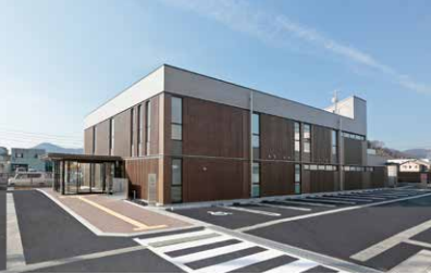
「福井地方検察庁武生支部新築工事」 設計の見直しに合致した施工計画を立案しながら、全工期無事故無災害で完成。工事評価点85点。
