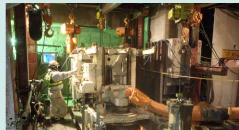
C-JET18による掘削状況
