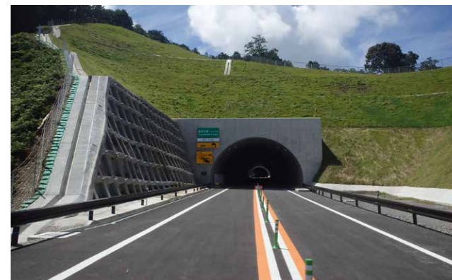
近畿自動車道紀勢線 富田第一トンネル工事(和歌山県白浜町)
