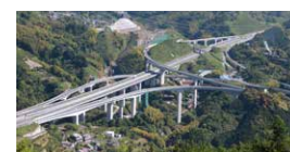
【中部横断自動車道 新清水ジャンクションランプ橋他4橋(PC上部工)工事】起点となるジャンクションに新たに5橋を建設中
