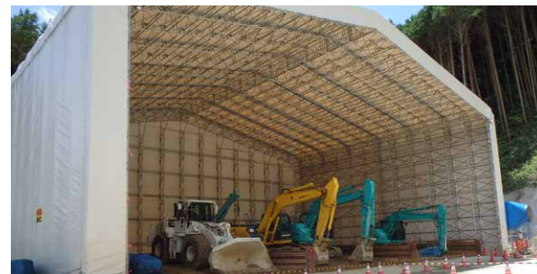
仕切りと養生テントを設けた掘削土砂仮置場
