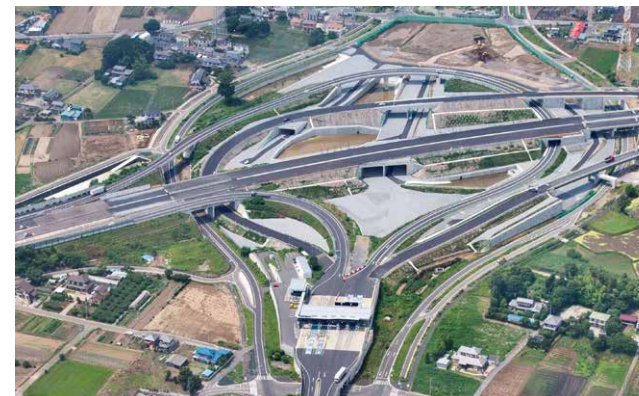
首都圏中央連絡自動車道 桶川北本インターチェンジ工事(埼玉県桶川市)
