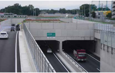
「圏央道・JR高崎線交差点二ツ家こ道橋新設工事」 工期短縮を実現すべく、地盤切削JES工法は本工事に初めて採用されました。
