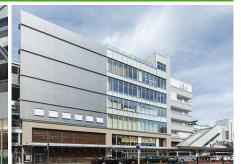
茅ヶ崎駅改良及び駅ビル増築他(神奈川県茅ヶ崎市) 店舗面積を1.8倍に広げ、地域に根差したショッピングセンターへ生まれ変わりました。改札口も広く、利便性も向上しています。
