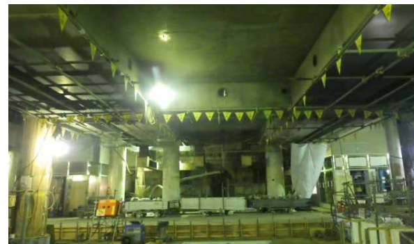
レンガアーチ高架橋をSRC高架橋へ改築
