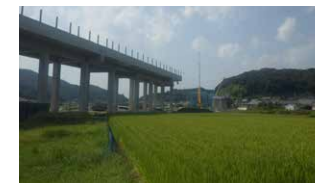
施工が進む、JV栄田高架橋作業所
