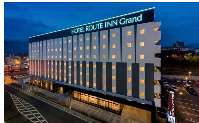
ホテルルートインGrand上田駅前(長野県上田市)
