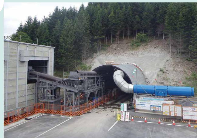
昆布トンネル坑口
