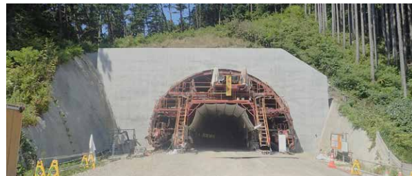
貫通後も工事は進み、坑門コンクリートの施工が完了した
