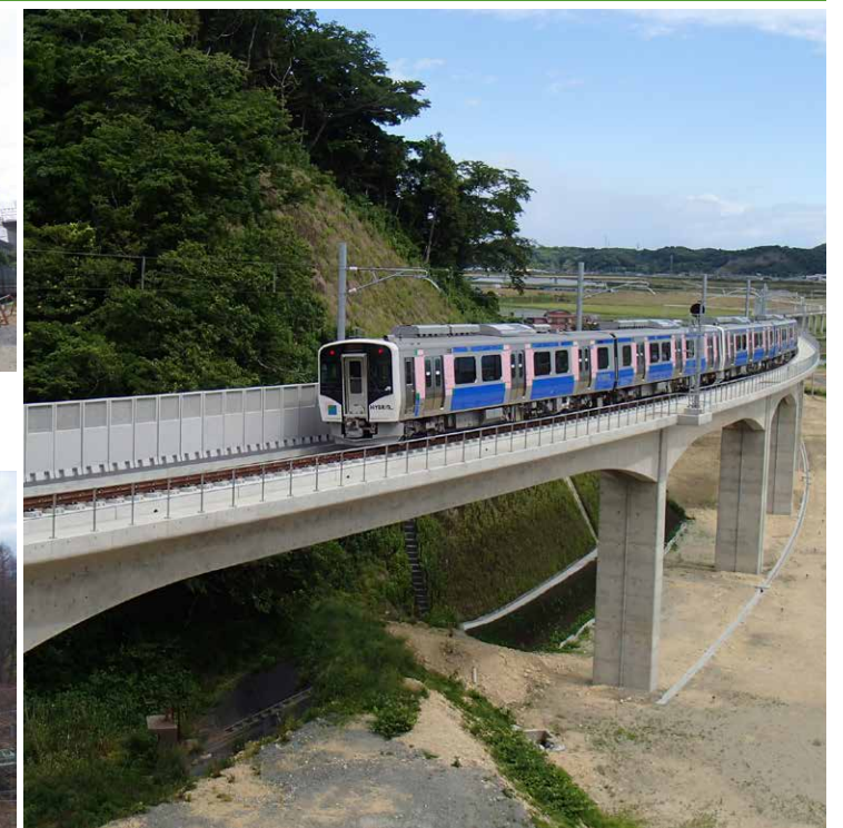
東北地方太平洋沖地震に伴う災害復旧(仙石線野蒜工区)(宮城県東松島市) 東日本大震災により甚大な被害を受けた仙石線は、地元の復興まちづくり計画に基づき、高台に移設し復旧しました。
