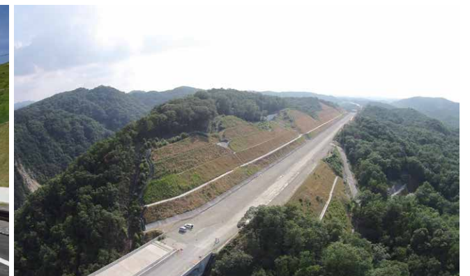
新名神高速道路 道場生野工事(兵庫県神戸市)
