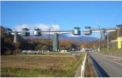
「中部横断自動車道 大石川橋上部工事」 水点下18℃にもなる冬季では、厳格な養生を行い品質を確保。工事評価点80点を獲得。
