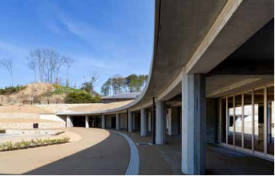
「キトラ古墳周辺地区体験学習館新築工事」 文化財を展示するため、防水性能など施工時に多くの対策を実施。工事評価点85点を獲得。
