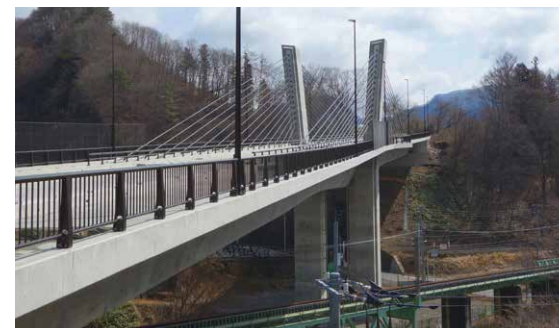
吾妻線長野原草津口・群馬大津間白砂川Bo新設(群馬県長野原市) 2径間連続PCエクストラード橋。JR吾妻線直上で電車架線との離隔が非常に少ない、難易度の高い工事です。
