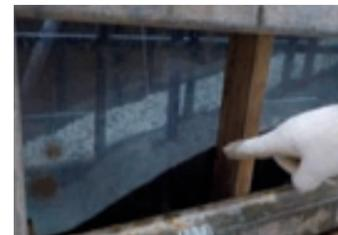
透明の型枠でコンクリートの充填を確認
