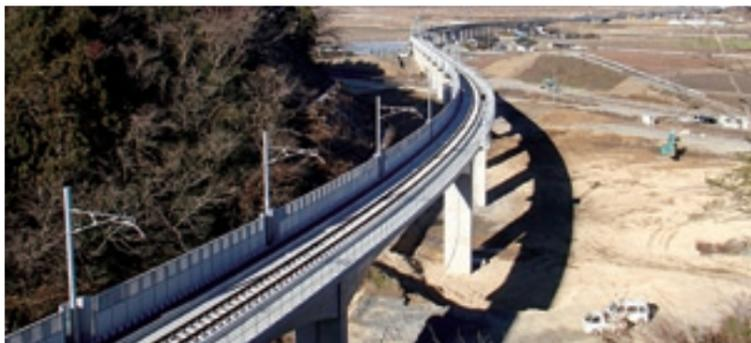
本工事は、JR仙石線陸前大塚～陸前小野間について、東名・野蒜の両駅を含めて、高台にルートを変更し復旧する工事です。既設高架橋は、比較的新しい構造物で、震災による被害も無かったことから、高架橋を切断、かさ上げさせ、勾配を変更して、再利用する工法で行いました。地元からの早期開業の期待に応えることができるよう、1日でも早い完成をめざしました。
