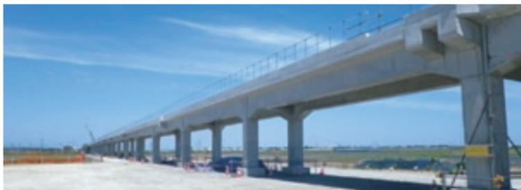
本工事は工事区間延長が約4.8km(移設区間の総延長は14.6km)もあり、高架橋区間・明かり区間・トンネル区間と様々な工種が混在し、多種多様な資材・機材の調達など多くの調整が必要です。また、いち早い復旧をめざし、昼夜作業はもちろん厳冬期も適切な養生を行ないながらコンクリート打設作業を続けました。地域の期待に応えるべく開通に向けて鋭意施工中です。
