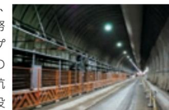
坑内左側に設置されたベルトコンベアー
