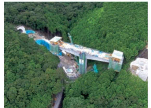
近畿自動車道紀勢線 南紀田辺IC～すさみIC(仮称)間で橋長142m、PC2径間連続ラーメン箱桁橋を片持架設工法にて施工しました。
