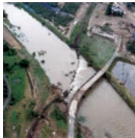
4基あった橋脚が根元から折れて橋桁が落下
