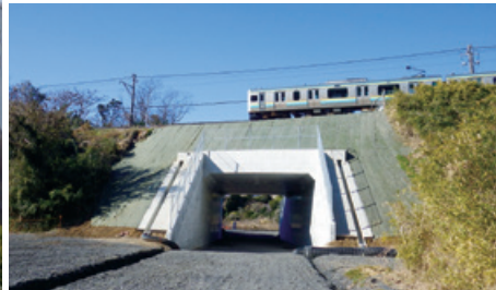
内房線岩井・富浦間南無谷こ道橋新設工事
