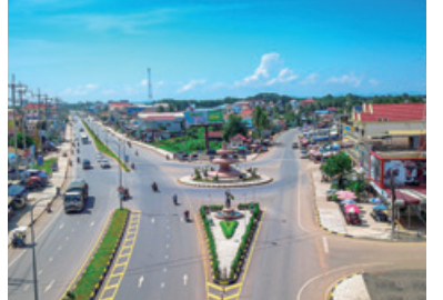
改修工事完了後のカンボジア国道5号線
