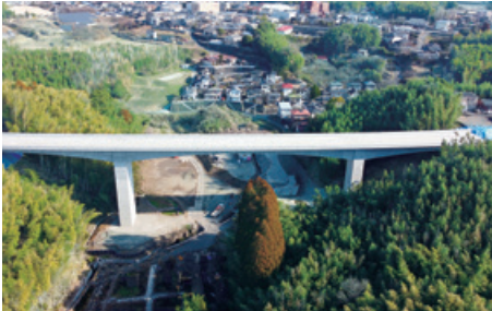
熊本3号 下硯川橋上部工工事 発注者 国土交通省
