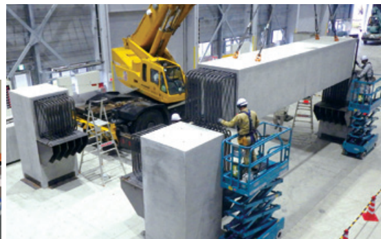
プレキャスト部材組立試験状況
