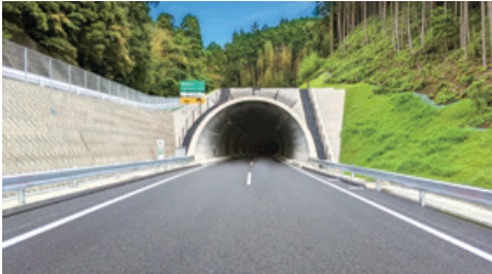
阪和自動車道 青垣内山トンネル工事 発注者 西日本高速道路株式会社
