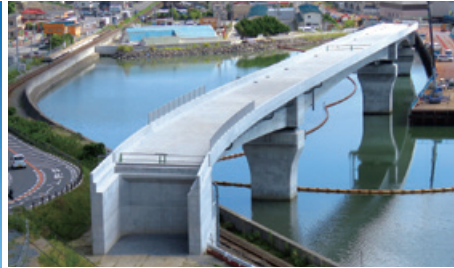
石巻線沢田・浦宿間浦宿こ線橋新設
