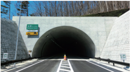
国道106号 松草トンネル工事
