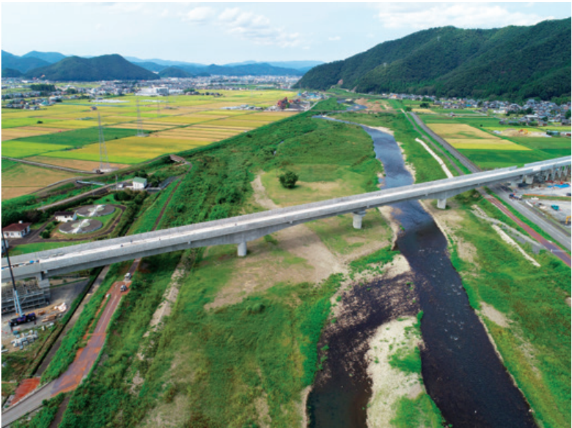
北陸新幹線、日野川橋りょう
