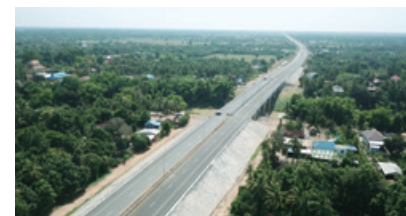
バイパス区間 Bridge78 STA7+810付近
