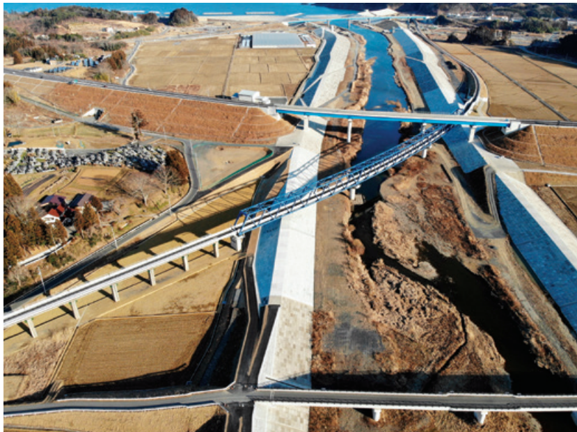
東北地方太平洋沖地震に伴う災害復旧(気仙沼線津谷川B改築)
