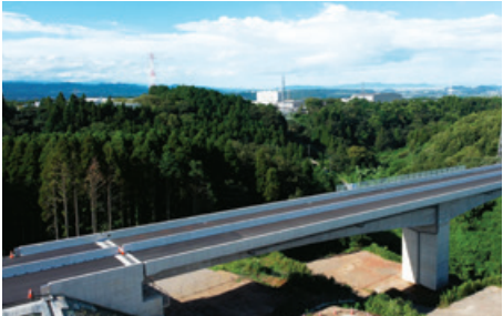
2019年度災害復旧 熊本57号高尾野橋上部工事
