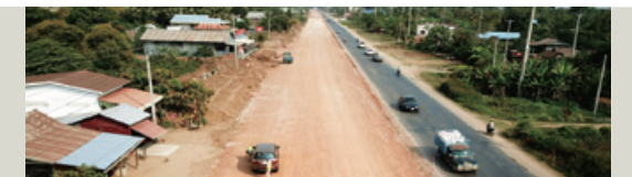
カンボジアで2件の道路整備工事を受注 総施工延長距離は90.4km
