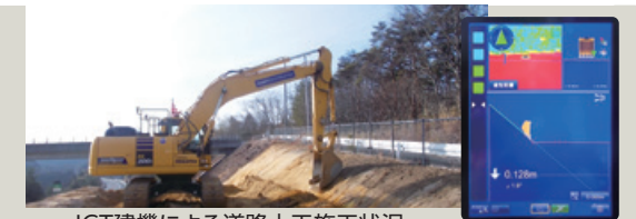
ICT建機による道路土工施工状況
