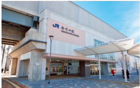
おおさか東線西吹田地区高架橋新設他工事
