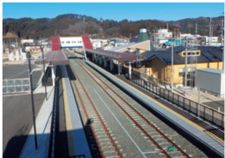
東北地方太平洋沖地震に伴う災害復旧(山田線復旧山田工区)
