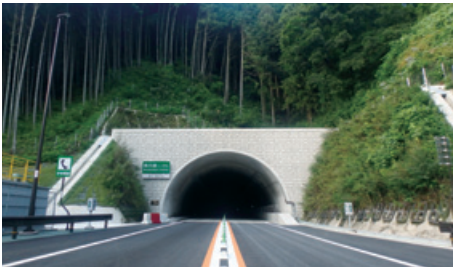
大和御所道路新田東佐味トンネル工事 発注者 国土交通省近畿地方整備局
