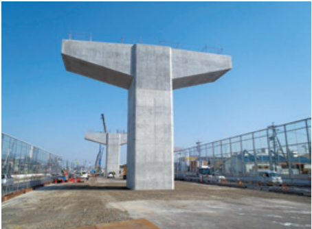
平成27年度 名二環春田2高架橋下部工事 発注者 国土交通省中部地方整備局
