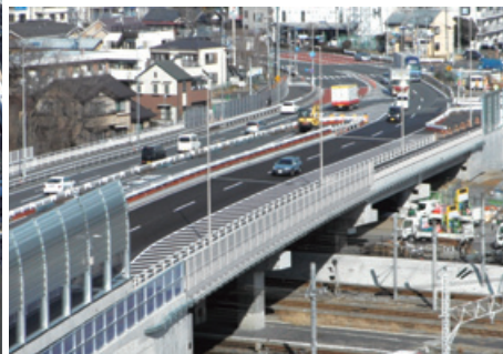
仙台駅構内武蔵野線橋架替
