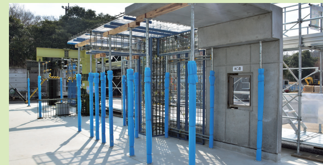
建築のRC造、S造、SRC造の施工実物大模型
