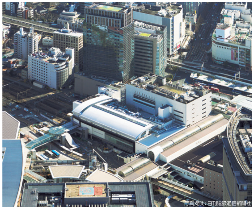
川崎駅北口自由通路新設・駅改良他
