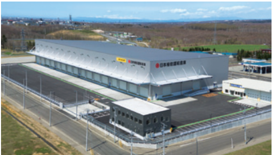
日本梱包運輸倉庫株式会社 苫小牧営業所輪厚倉庫 発注者 日本梱包運輸倉庫株式会社
