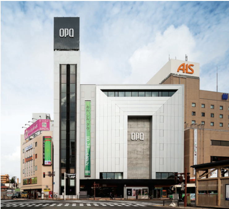
秋田フォーラスリファイニング工事 発注者 有限会社すぐる不動産
