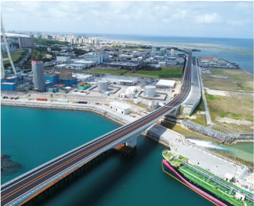
平成27年度 牧港高架橋上部工 (P7～A2) 工事 発注者 沖縄総合事務局
