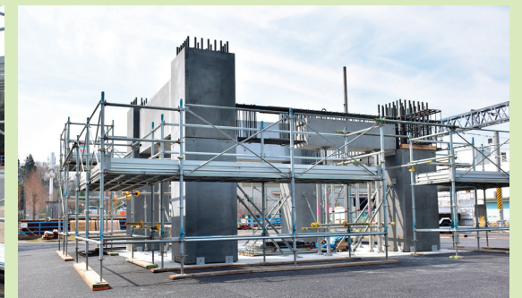
超高層住宅のプレキャスト施工実物大模型
