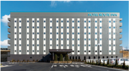
ホテルルートイン宇都宮ゆいの杜新築工事 発注者 ルートインジャパン株式会社
