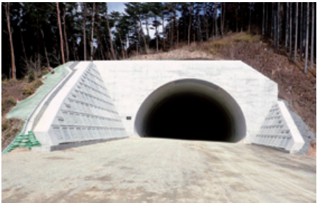
国道45号 気仙トンネル工事
