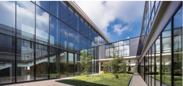
鎌倉市立大船中学校改築工事
