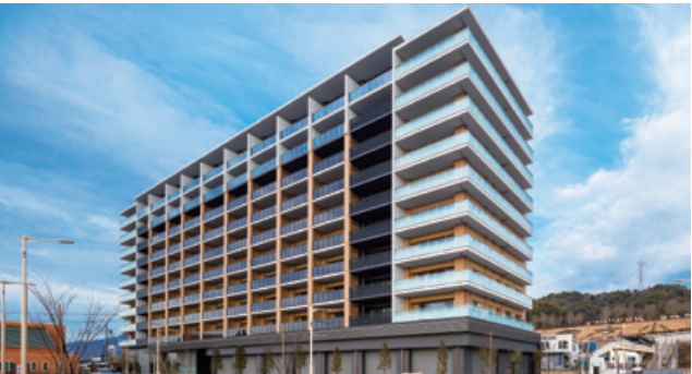
廿日市駅北プロジェクト新築工事
