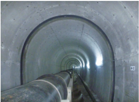
横浜環状南線 金利谷地区整備工事(内巻き補強)
