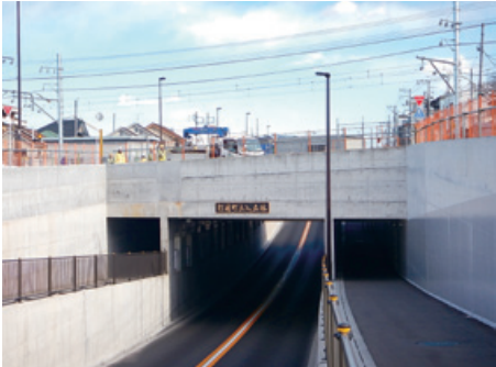
横浜線片倉・八王子間打越地道橋新設2 発注者 東日本旅客鉄道株式会社
