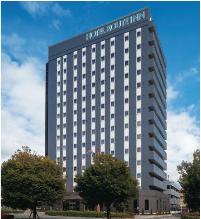
ホテルルートイン東広島島西条駅前新築工事
