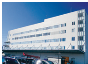
株式会社東京精密八王子第6工場外観
