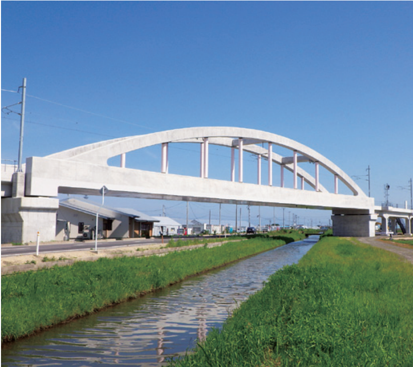
東北地方太平洋沖地震に伴う災害復旧(常磐線山下工区) 発注者 東日本旅客鉄道株式会社
