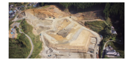
2015年10月 着工前全景
