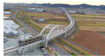
常磐線山下作業所(新井田承水路橋りょう)
