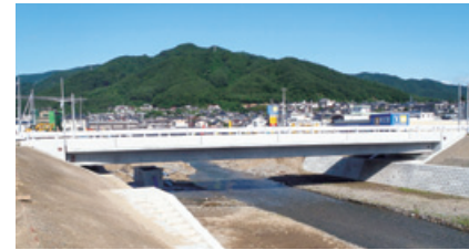
大船渡作業所(須崎川橋りょう)
