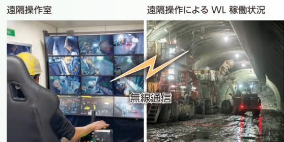
ホイールローダ遠隔操作システム（Tunnel RemOS-WL）の現場適用試験状況
