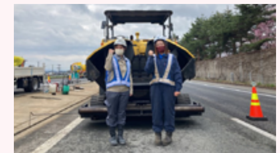
けんせつ小町工事チーム（土木）：SHIZUKU小町
