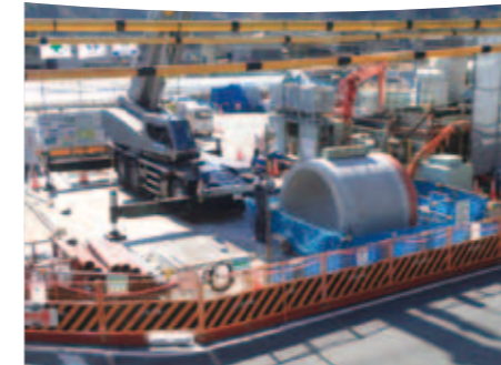
発達立坑基地全景
