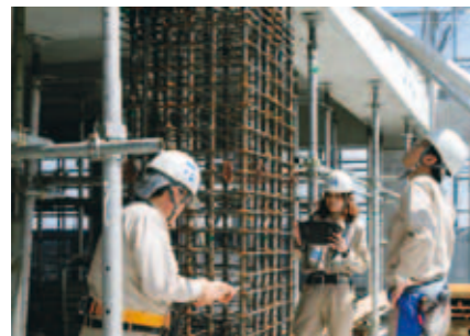
鉄筋の配筋状況の確認
