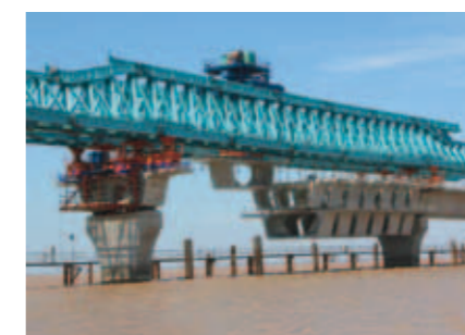
プレキャストセグメントスパンバイスパン工法を採用したラックフェン国際港建設工事(道路および橋梁)
