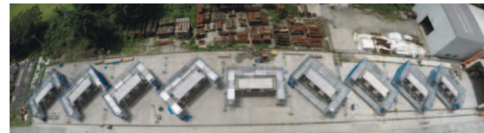
躯体打設完了全景
