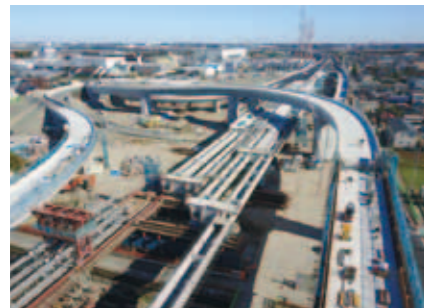
プレキャストU桁セグメント工法を採用したPC上部工工事
