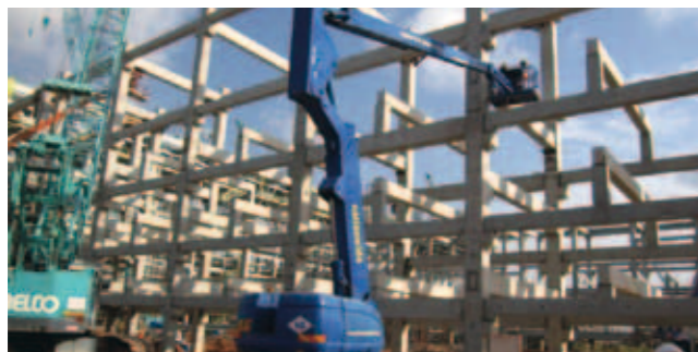
マレーシアでのプラント工場(パイラック)の施行状況
