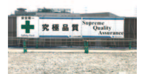
現場に掲げられた「究極品質」横断幕と「安全第一・緑十字」シート
