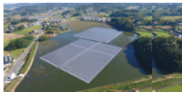
平木尾池ソーラー発電所（香川県/自社事業）
