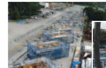
型枠組立状況全景
