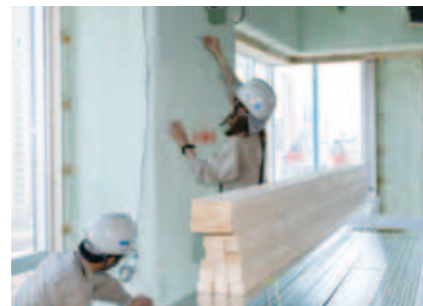
断熱材の吹付厚さの確認
