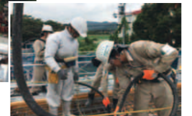
コンクリート打設状況
