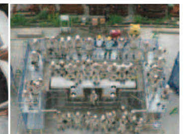
2主版桁打設完了
