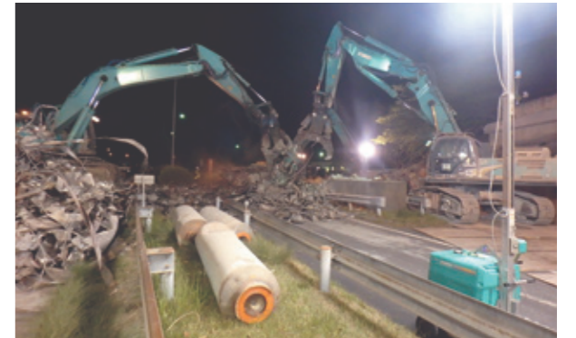
府領橋撤去工事
