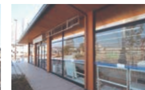
木造コンビニエンスストア(神奈川県海老名市)
