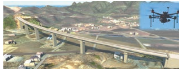
自動作成した橋梁とドローンにより取得した地形との合成図
