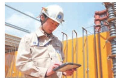
タブレットPCを使用した配筋検査
