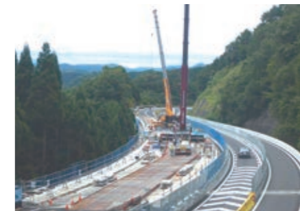
プレキャストPC床版架設状況
