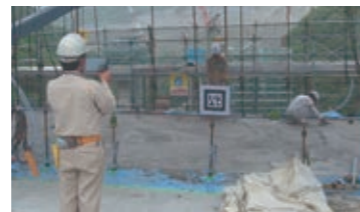
タブレット端末による高さ管理状況
