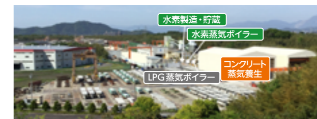
水素製造装置を導入した能登川工場
