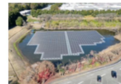
オンサイトPPAモデル(工場内の調整池における水上太陽光発電事業)
