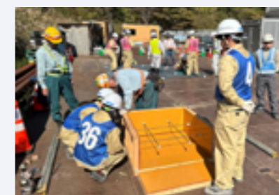
鉄筋結束の作業を体験する様子
