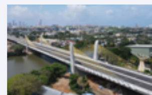
ケラニ河新橋建設事業パッケージ2 エクストラード橋工区
