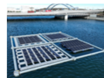
洋上浮体式太陽光発電施設 (東京都)
