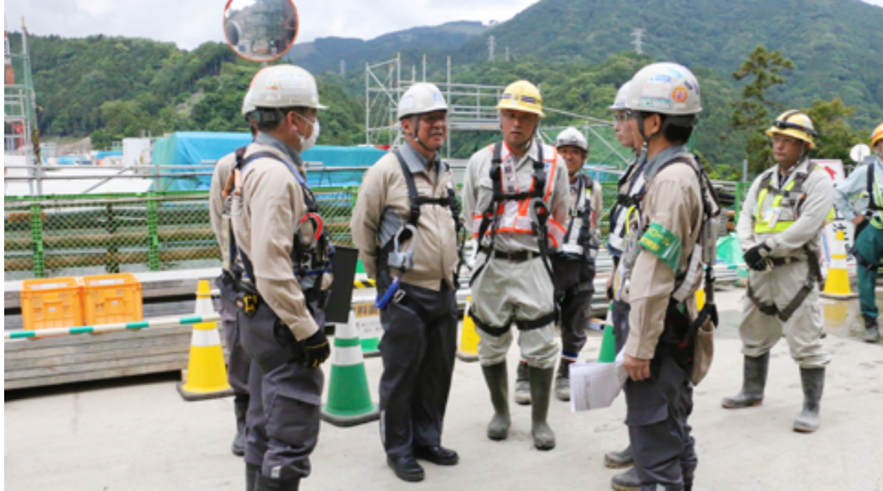
新東名高速道路 山北皆瀬川工事
