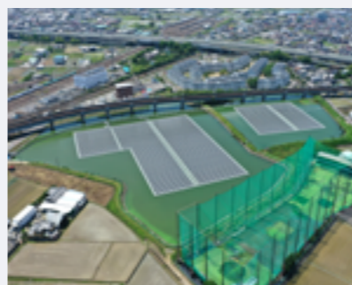
泉佐野市長滝 第1/第2水上太陽光発電所(大阪府)
