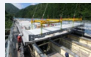
作品賞(改築・改修部門) 蓼野第二橋(下り線)床版取替
