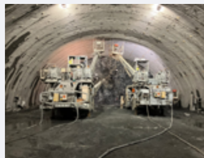
宮崎218号童里トンネル新設工事(宮崎県)
