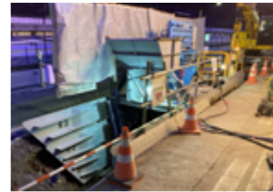
クイックreインバート工法(メッセルシールド機使用)
