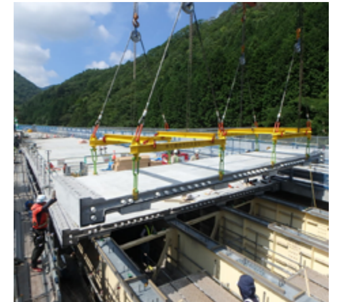
蓼野第二橋他3橋床版取替工事(島根県)
