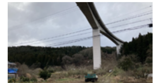
大規模地震災害の影響による緊急復旧工事(能登大橋)
