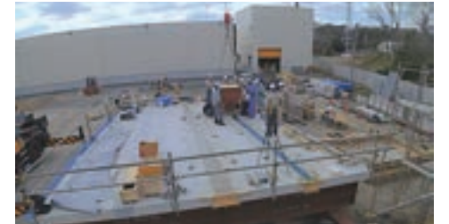
当社R&Dセンターで実施した実物大施工試験
