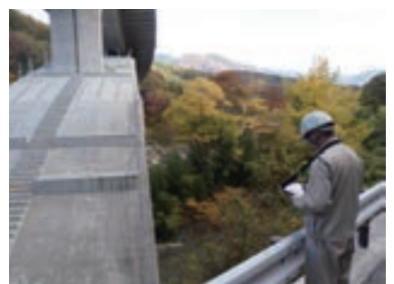
タブレットアプリを用いた橋梁点検の様子
