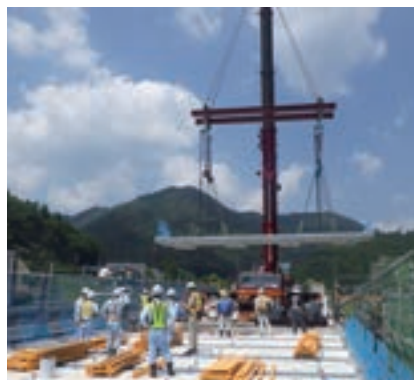
中国自動車道(特定更新事業)西川橋床版取替工事
