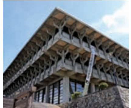
津山文化センター(岡山県)耐震補強及び大規模改修事業
