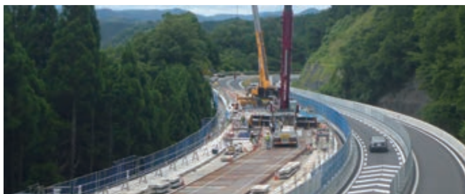
3橋同時床版取替(中国道大峰橋他2橋)
