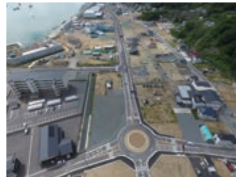
宮古市鉾ヶ崎・光岸地区整備工事(岩手県)
