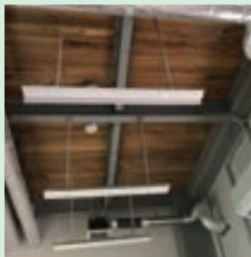
2階のスラブ下に MIデッキ
