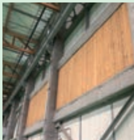
耐震壁に CLTパネル
