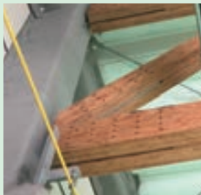
鉄骨と木造の ハイブリッド構造
