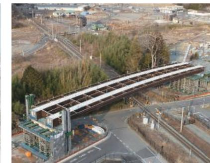
送出し工法による橋桁架設完了
