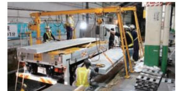
ホーム工事のPC板の運搬・敷設作業を1台で可能とする、軌陸式門型クレーン
