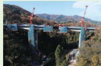
中国横断自動車道岡山米子線の暫定2車線区間において、当社は宮地川橋(PRC3径間ラーメン箱桁橋)と上宮地川橋(PRC5径間連続2主版桁橋)の2橋を施工しました。交通事故等に対する安全性の向上及び災害時のリダンダンシーの確保を目的として、全線4車線化事業が進められています。
