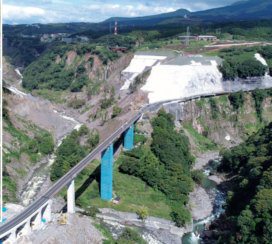
阿蘇長陽大橋外補修工事 (国土交通省 九州地方整備局)
